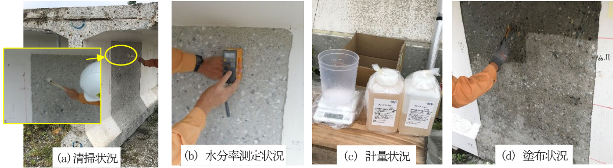
写真 4.3.1 含浸材塗布作業状況
