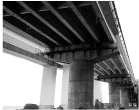
D橋表面含浸（手前）と表面被覆（奥）の状況
