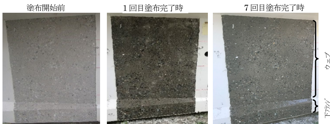
写真 4.3.2 含浸材塗布時の状況（桁端部）
