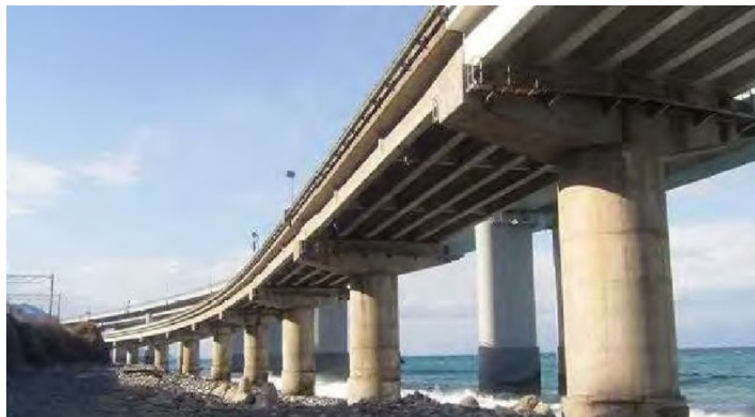
写真 1.1.1 本研究で対象とした調査橋梁の全景
