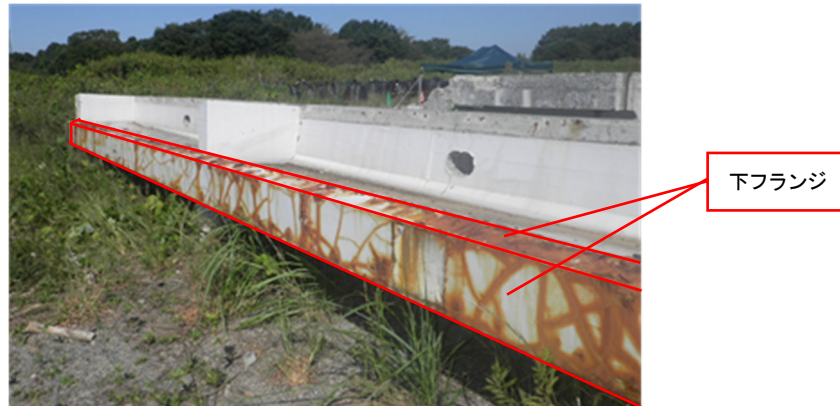
写真 5.2.1 調査対象 PC 桁の保管状況（土木研究所敷地内）
