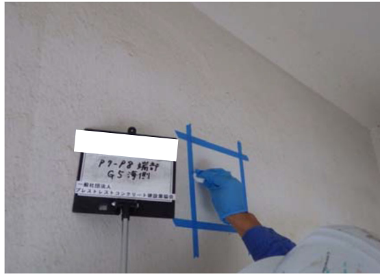
写真 2.5.4 拭き取り法の調査状況（ウェブ拭き取り状況）
