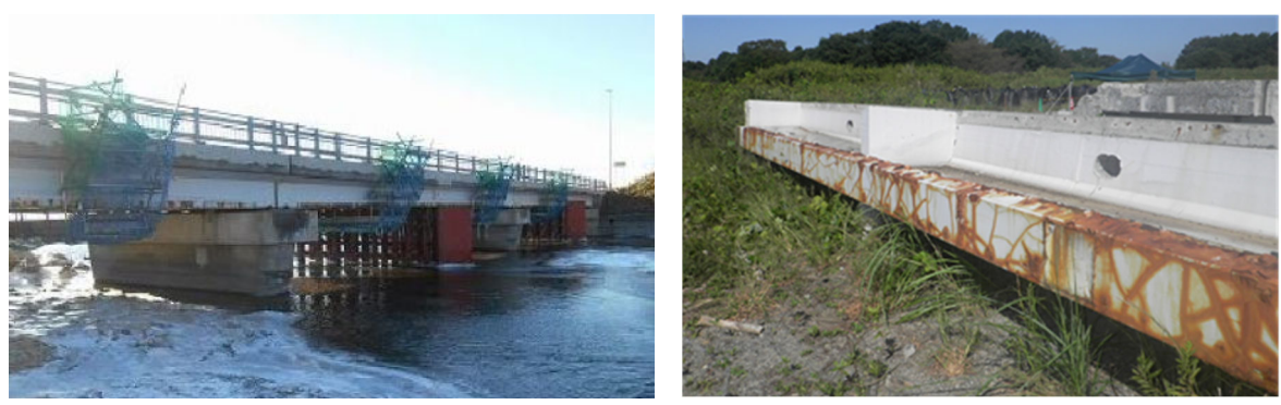
写真 1.1.2 撤去橋梁の全景（左）と譲り受けた鋼板接着された主桁の一部（右）
