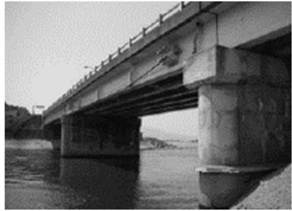
B橋外ケーブル設置後の状況
