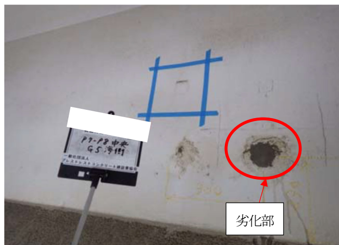
写真 2.4.1 劣化部の例
