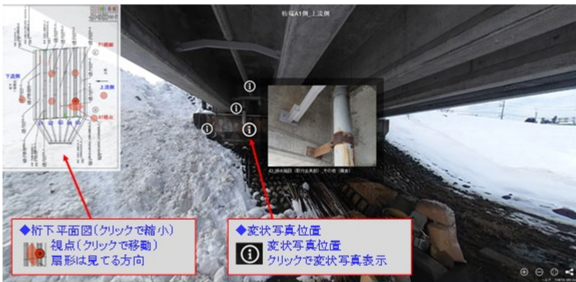
図4-2-16 SI橋 PCT桁(第1径間) [360度画像]
