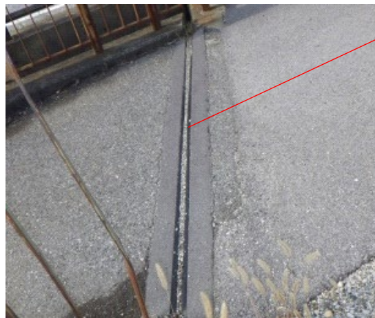
図3-12-9 突合せ型ゴムジョイント
