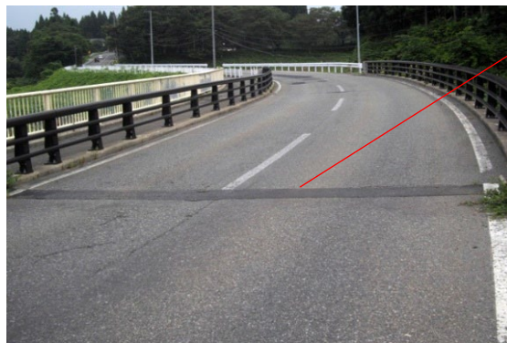
図3-12-8 埋設型ジョイント
