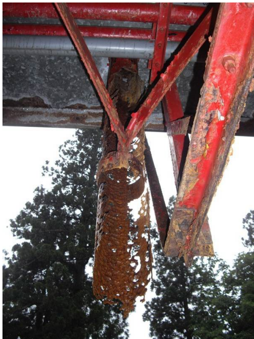
図 3-13-7 鋼製排水管の著しい腐食事例 59)
