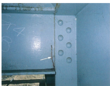
1) 横桁と縦桁の接合部 11)
