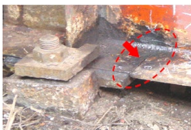
1) 主桁下フランジの支承ソールプレート溶接部
