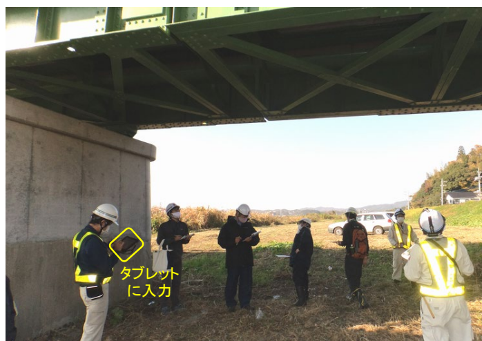
写真4-1-2 現場でのシステム使用状況
