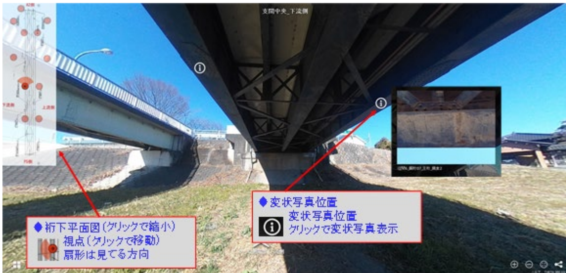
図 4-2-12 S 橋 鋼 I 桁 (第 6 径間) [360 度画像]
