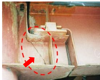
2) 桁端切り欠き部
