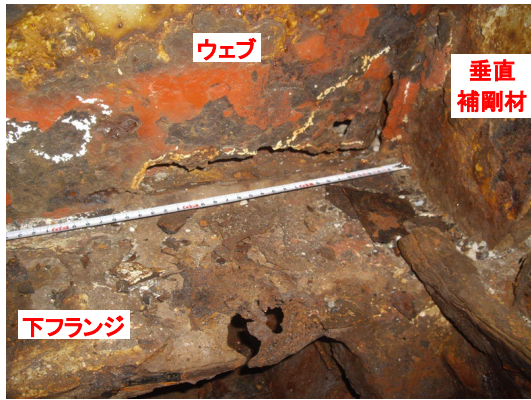
図 3-12-4 桁端部の腐食と断面欠損 32) (内桁の支承上、支間側の角)
