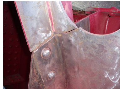
3) 斜材とガセットプレートの連結部 12)
