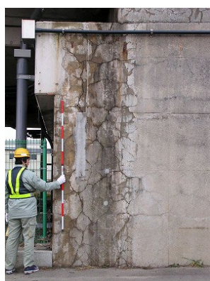
1) 橋台堅壁側面部
