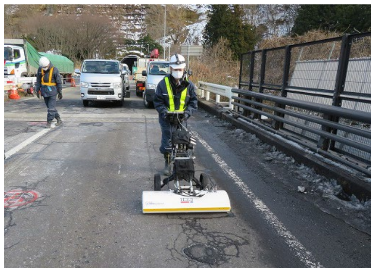
写真-4.5.1 探査状況
