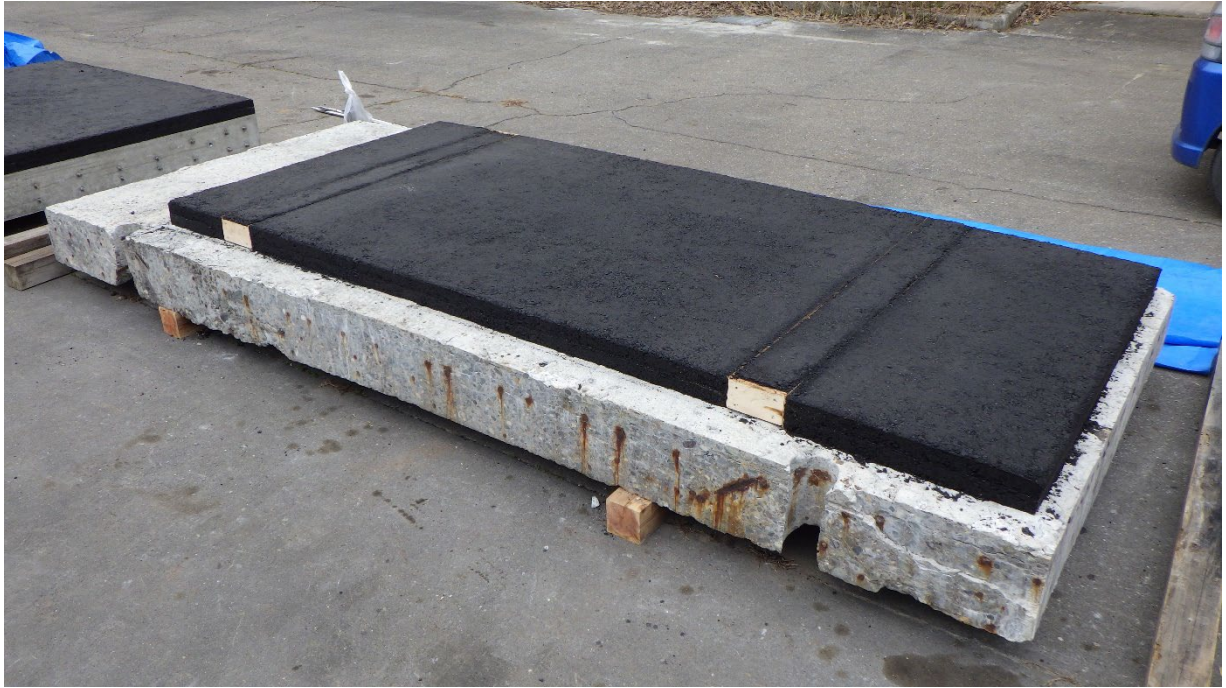
写真-5.1.12 舗装舗設完了状況（撤去床版活用供試体 No.1）
