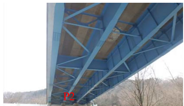
(h) 第3径間 (P2-A2) 下面
