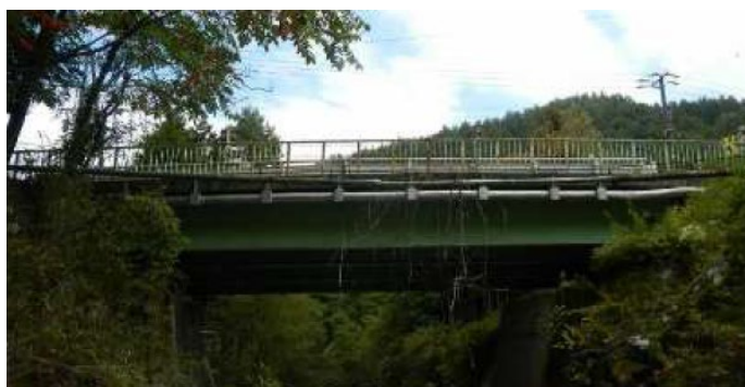
写真-6.1.1 I 橋 外観写真
