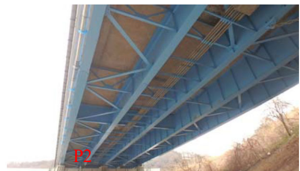
(h) 第3径間 (P2-A2) 下面
