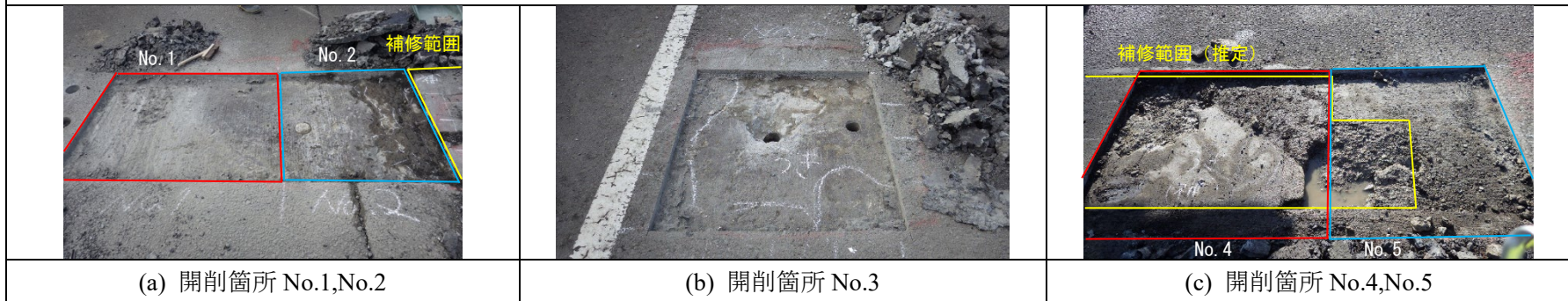
図-3.2.3 開削後の床版上面の状態
