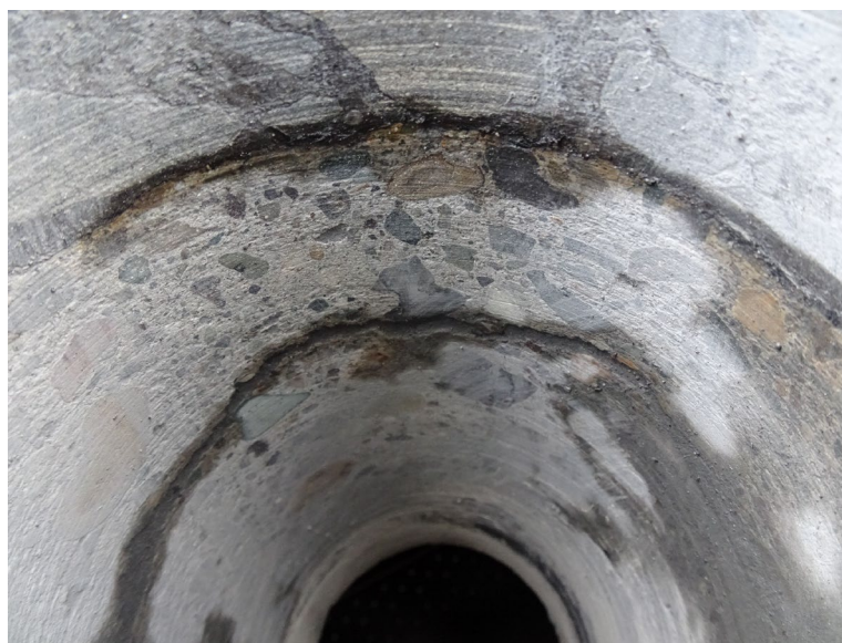
写真-3.5.3 Core-02 採取後の削孔穴
