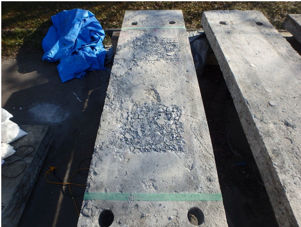
写真-5.1.9 はつり箇所にはつりがらを敷き詰めた状況（撤去床版活用供試体 No.2）
