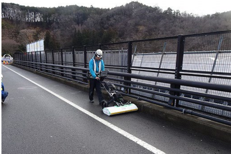
写真-3.4.1 探査状況
