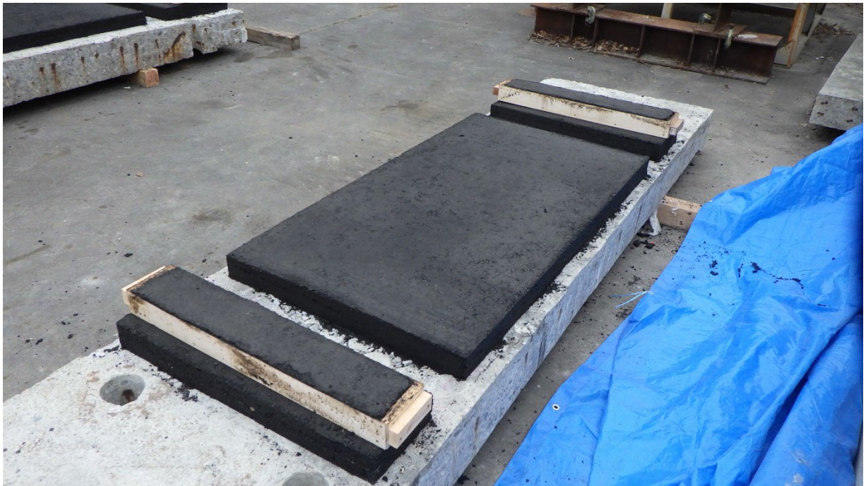
写真-5.1.11 舗装取り外し状況（撤去床版活用供試体 No.2）
