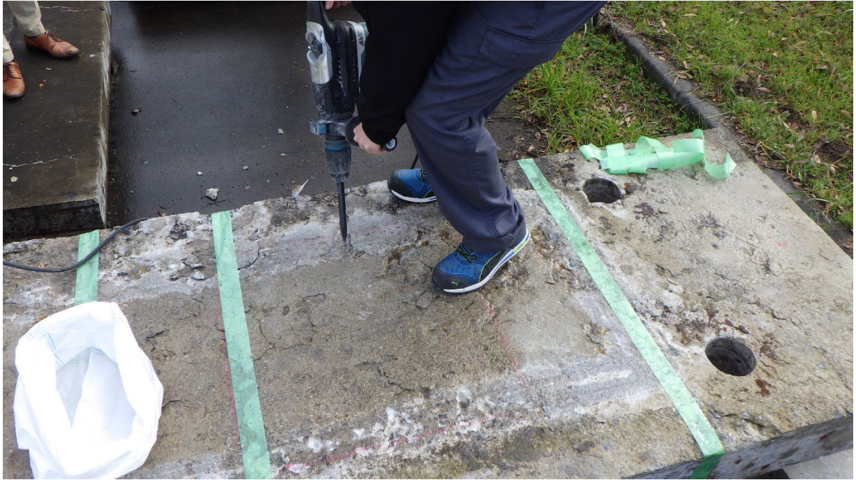
写真-5.1.4 ブレーカーによるはつり状況（撤去床版活用供試体 No.2）
