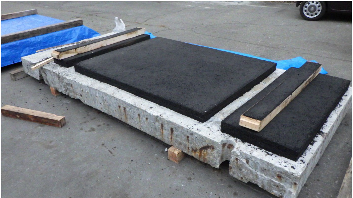
写真-5.1.13 舗装取り外し状況（撤去床版活用供試体 No.1）
