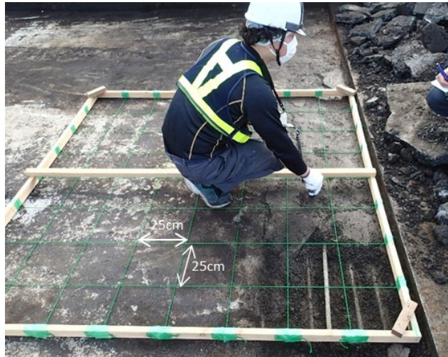
写真4.3.1 床版上面水分量の測定状況
