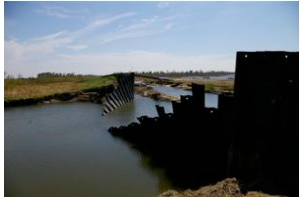
(位置5) 背後にPipeline Canalがみえる。
