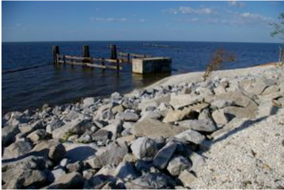
ポンプ排水の放水口。
