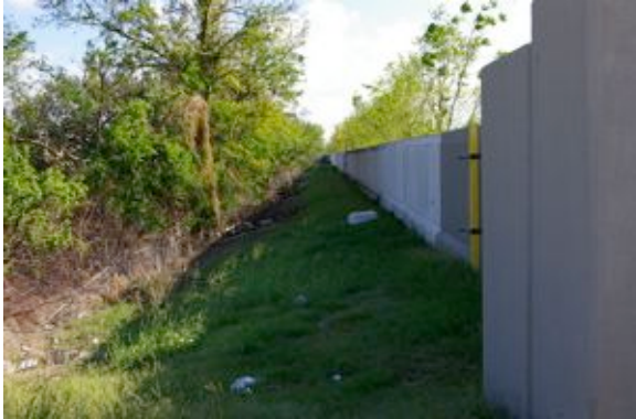
破堤地点対岸の堤防。
