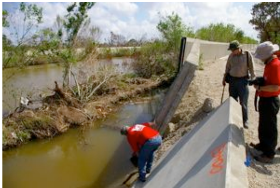
Floodwallの前面に水面に少しだけ矢板が顔を出している。
