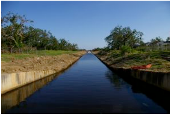
ポンプ場につながる水路。Floodwallはない。
