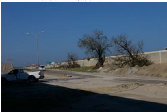
Floodwallの上に流木が乗っている。
