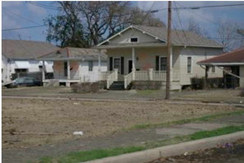
写真-2 FEMAが避難状況を確認した住宅
