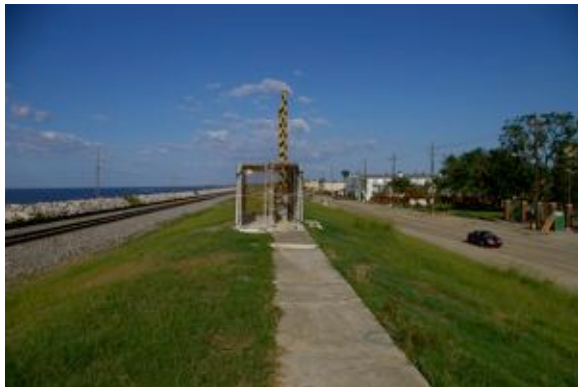
堤防中心に設けられた樋管ゲートとその背後の道路を隔てて設置しているポンプ場
