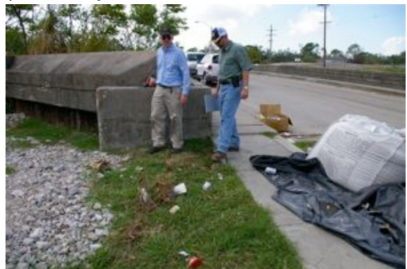
橋が一番低く、取り付け、矢板、Flood wallの順に高くなっている。
