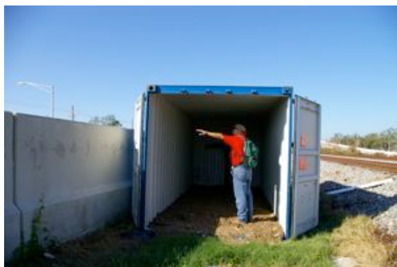
コンテナの近くでfloodwallに残されたごみ。堤内地側は洗掘されていない。
