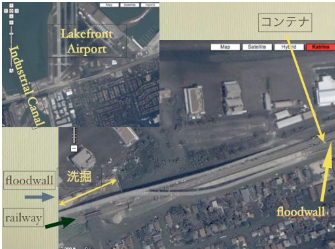
中央左下、鉄道の南側に白く見えるのが越流した高潮で線路の堤内側の堤防が欠けて堆積した砂である。高架橋を挟んで北側にfloodwallがほぼ直角に曲がっているのが見える。
