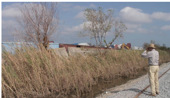
破堤地点1 Floodwall破堤部の堤外側。
