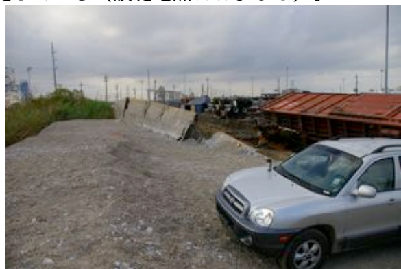
破堤地点1 破堤部の応急復旧状況。
