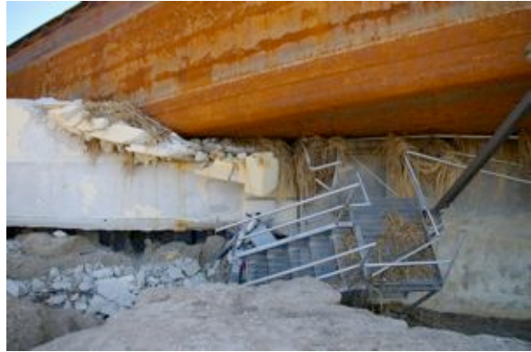
コンクリートI型floodwallの背面が洗掘されているにもかかわらず、バージの乗り上げに抗して倒れてはいない。（位置4）
