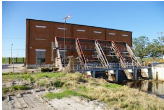
堤防中心に設けられた樋管ゲートとその背後の道路を隔てて設置しているポンプ場
