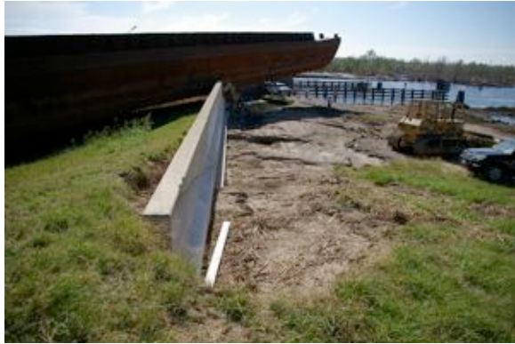
コンクリートI型floodwallの背面が洗掘されているにもかかわらず、バージの乗り上げに抗して倒れてはいない。（位置4）
