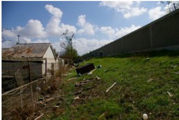
土堤の天端幅は狭い。
