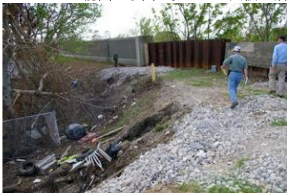
橋が一番低く、取り付け、矢板、Flood wallの順に高くなっている。
