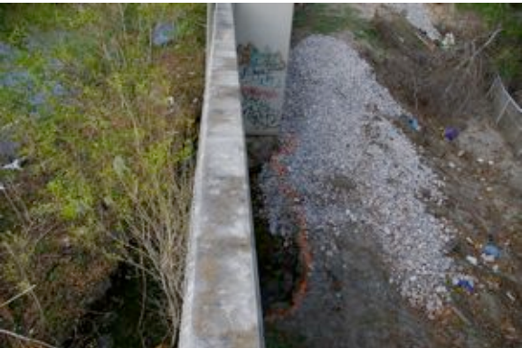
右の写真は陥没のみられる部分を上から見たものであるが、外側の水面はfloodwallに沿ってつながっている。
