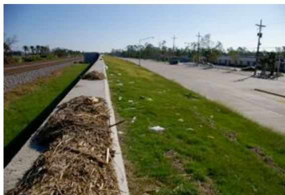
コンテナの近くでfloodwallに残されたごみ。堤内地側は洗掘されていない。
