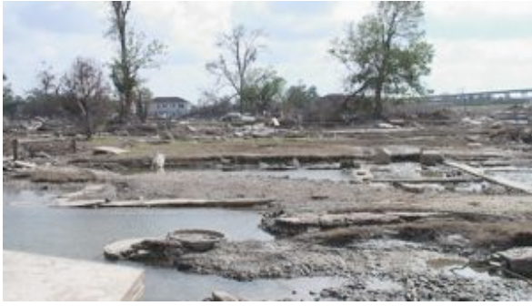
住居がことごとく流失し基礎だけが残っている。
