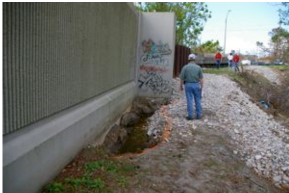
橋が一番低く、取り付け、矢板、Flood wallの順に高くなっている。
