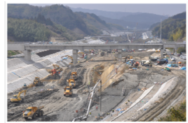
斐伊川放水路建設工事
