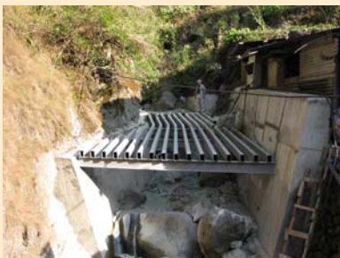
土石流減勢工(または土石流ブレーカー)下流から撮影
