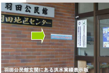
羽田公民館玄関にある洪水実績表示板
