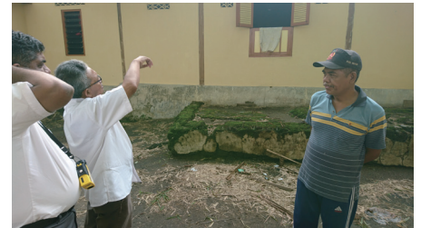
Hearing from local residents about flood damages 地元住民から過去の洪水被害のヒアリング
