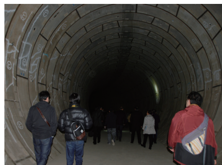
Inside the tunnel トンネル内
