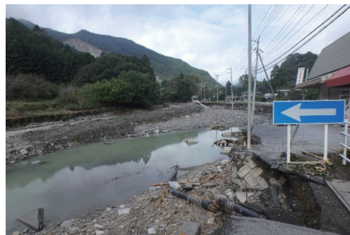
Photo 1. Bank erosion in Mizuki Machi 写真 1 水木町の河岸侵食
