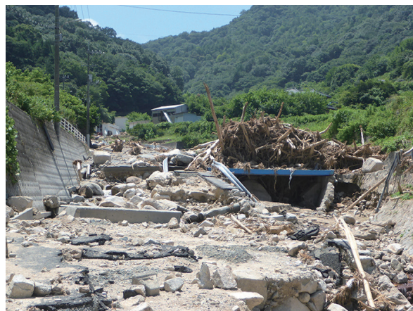
Photo 1 An example of channel changes and bed deformation caused by sediment deposition with driftwood (Photo taken on 23rd of July, 2018, in the Sozu River basin) 写真1 土砂と流木の堆積による流路・河床変動の例 (2018年7月23日、総頭川にて撮影)
