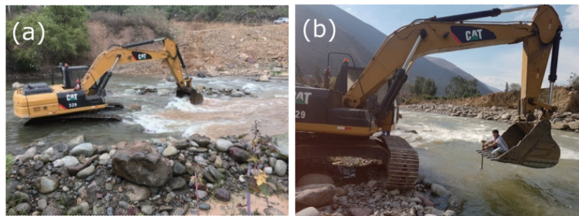
Photo 2 Making a trench with a heavy machine (a) and conducting a topographic survey of the trench (b) 写真2 重機で川底に溝を掘っている様子 (a) と溝の地形測量を行っている様子 (b)
