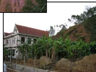
土砂崩れの跡地に建てられた 新築の豪邸(フエ省)
