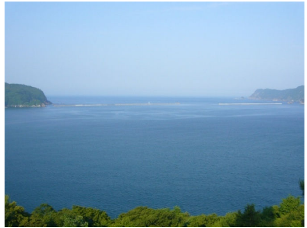
写真 3-2-10 釜石湾口防波堤 (釜石大観音から遠望)
