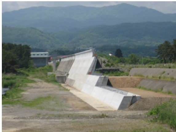
写真 3-2-3 野田村で建設中の津波堤防
