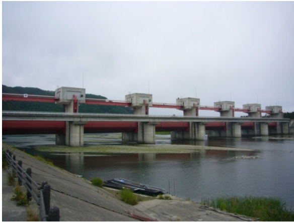
写真 3-2-7 小本川水門全景
