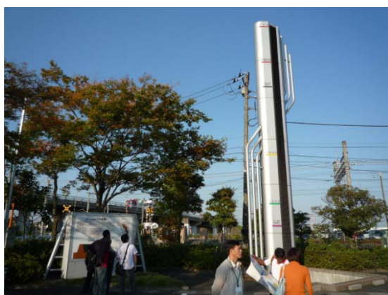
写真 4-18 栗橋町役場前の水位表示板
