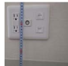
รูเสียบของช่องต่อสัญญาณหลัก (Modular jack)กับเต้าเสียบไฟฟ้าสูงจากพื้น 20 ซม.
