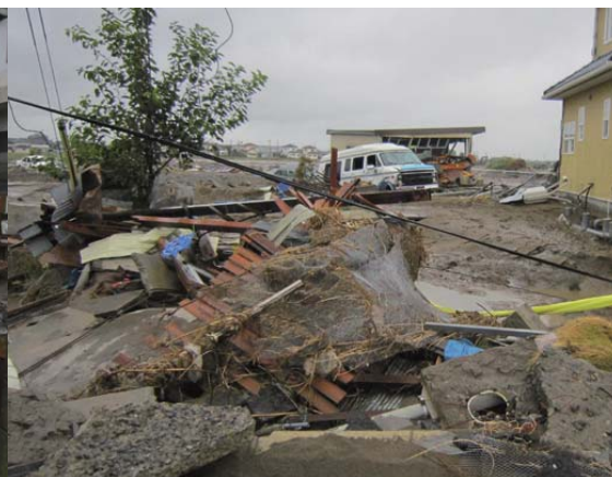
写真-B.9 破堤地点近くの様子
