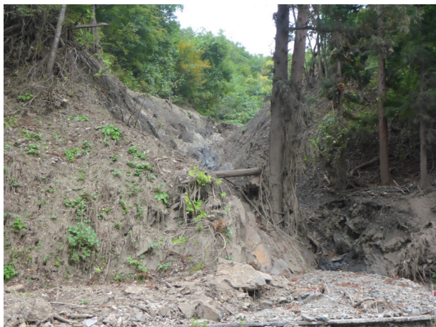
写真 3.2-5 大沢川（大川の支川）、土石流が発生したとみられる
