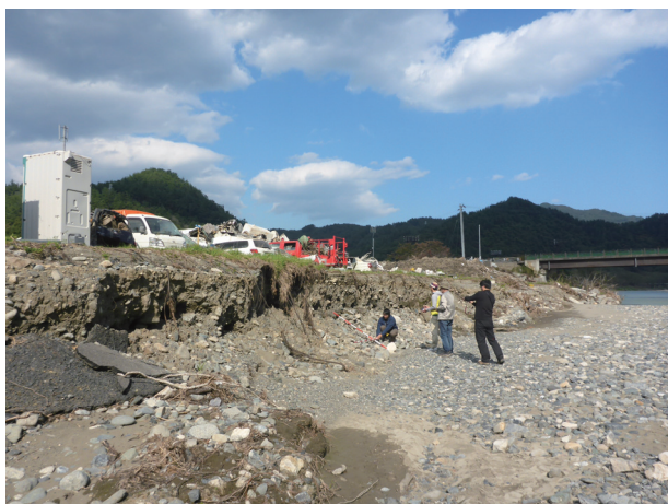
写真 3. 2-19 小本川、道の駅いわいずみ前の河床、河岸に侵食崖が形成されている
