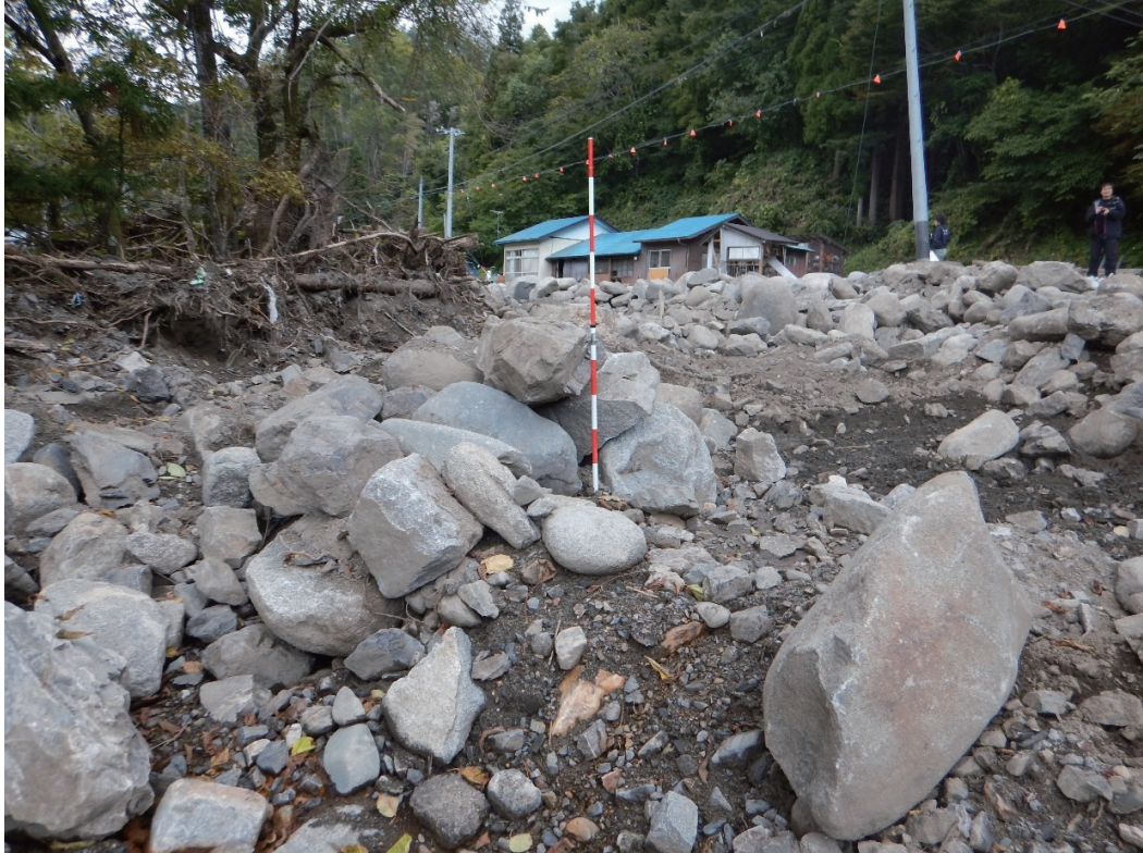
写真 A-4 鼠入川河道内の状況 湾曲部では多くの巨礫が露出している (写真奥が上流) (写真 3. 3-1 の付近)
