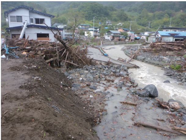
写真 3.2-3 三田貝川と小本川の合流点付近、流された橋の一部が河道内に残る
