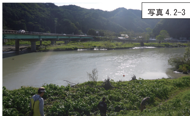
(河口付近) • 川幅: 200 m • 痕跡水位からの水深: 6.0 m • DEMから読み取った河床勾配: 1/800 • 粗度係数を0.04と仮定してマンニング式から算定される流速: 2.92 m/s 推定ピーク流量: 3,502 m 3 /s 降雨流出解析ピーク流量: 2,904 m 3 /s
