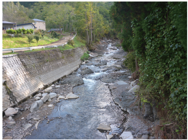
写真 3. 2-12 鼠入川、土砂により河床が一時的に上昇した後、侵食
