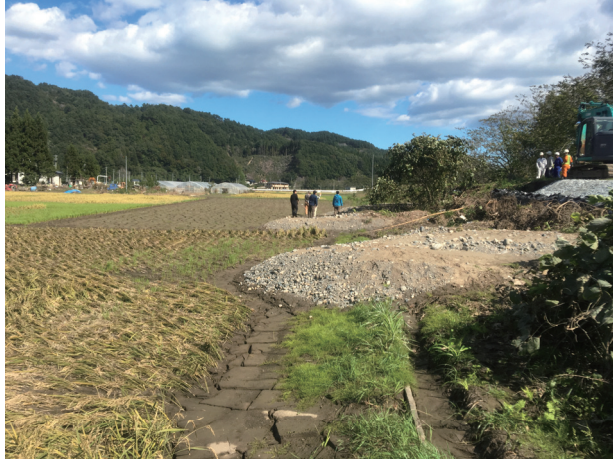
写真 3. 2-29 小本川、写真右手奥が下流、左岸堤防の損壊
