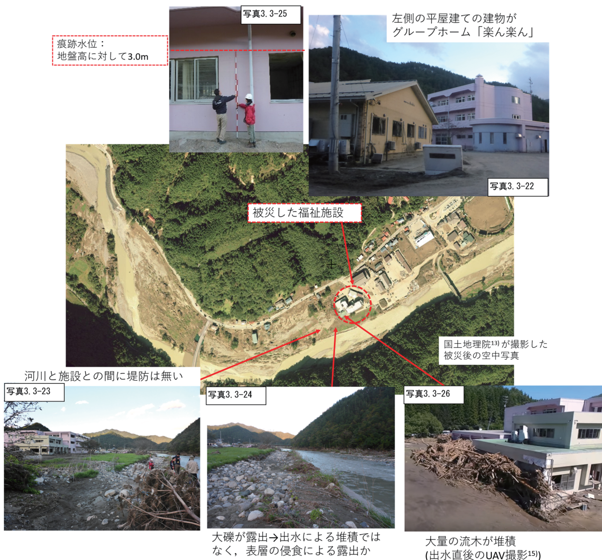
図 3.3-7 乙茂地区中心部の被災状況
