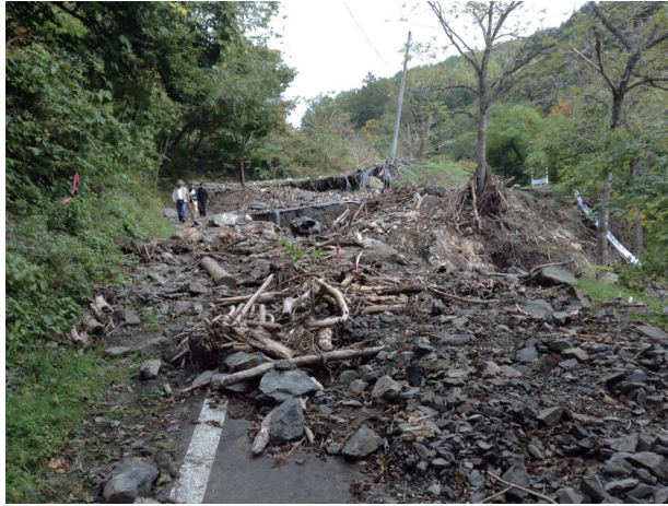
写真 3. 2-11 大沢川、土砂や流木により道路が損壊
