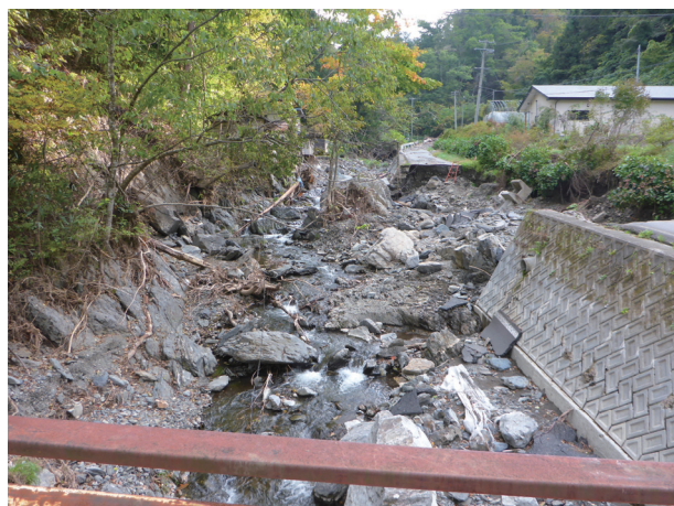
写真 3.2-8 大川、写真奥が上流側、土砂により河岸の道路が寸断される
