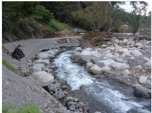
写真 3. 2-14 鼠入川、堆積した花崗岩の円礫は直径 1m 以上
