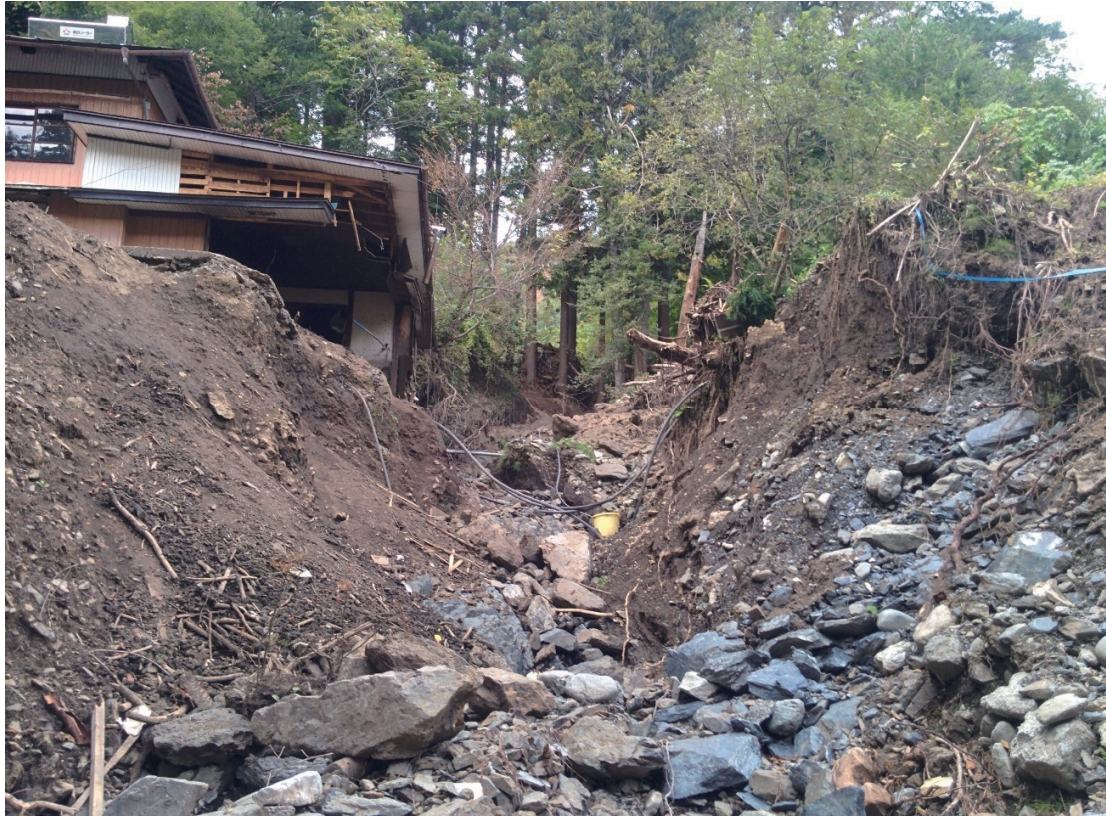
写真 A-6 大沢川の支流の土砂堆積物の状況 (写真 3.3-7 の付近) (写真奥が上流)
