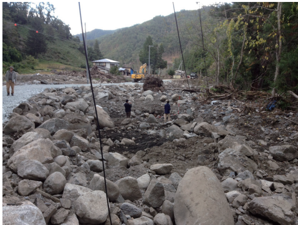
写真 3. 2-13 鼠入川、写真右手前から奥に流下、河岸を超えて土砂が堆積
