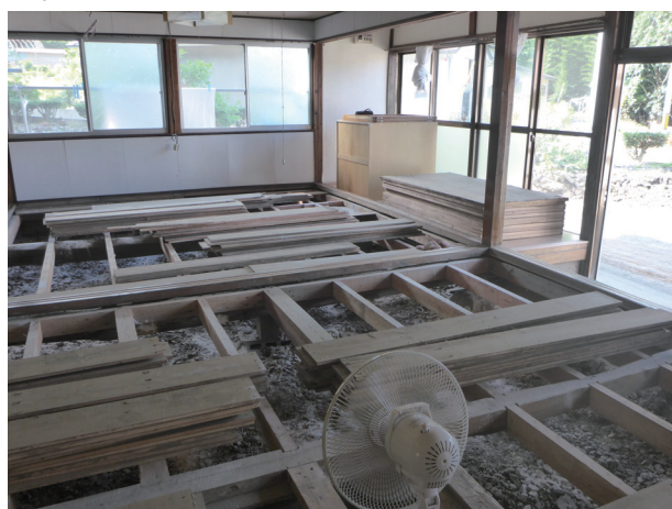
写真 3. 2-28 小本川、中島地区卒郡の家屋、床上浸水したため、床板をあげて乾燥作業中
