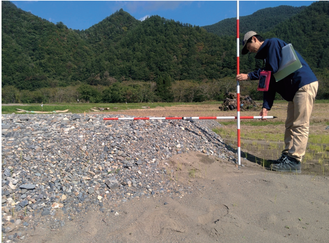
写真 A-10 褒野地区の氾濫堆積物 破堤によって堤内地（農地）に流入した土砂 厚さが 60cm 程度堆積している（図 3. 3-5 参照）
