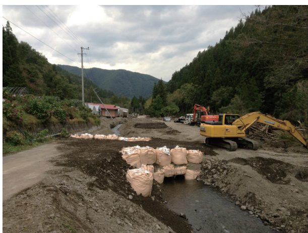
写真 3.2-9 大川、土砂が河岸を超えて谷全体に堆積、写真右手にあった河道が左手に移動
