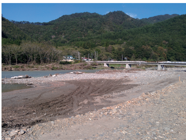
写真 3. 2-21 小本川、写真左手が上流、赤鹿橋の欄干が損傷
