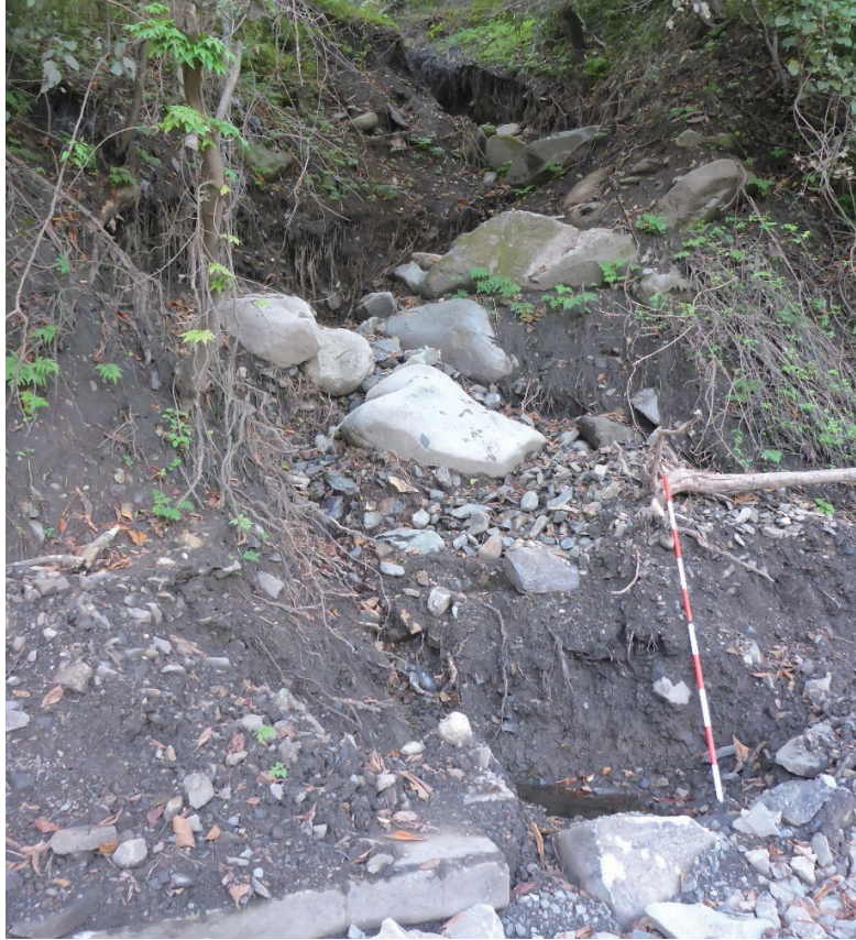
写真 A-8 鼠入川の支川の土砂堆積物の状況（写真奥が上流）
