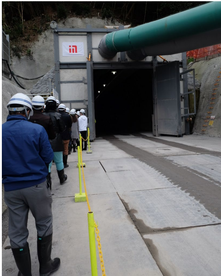
日下川新規放水路工事現場(2月27日)
