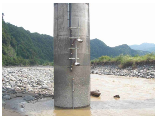
図-17 音響測深機の設置状況①
