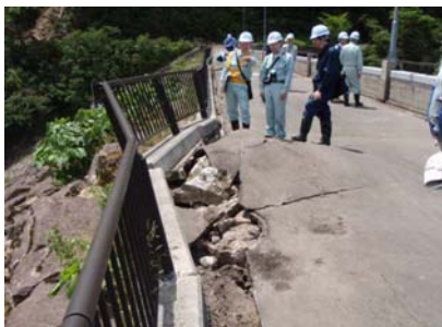
ダムの安全性確認（石淵ダム）
