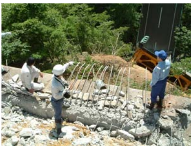
落橋した祭時大橋の調査
