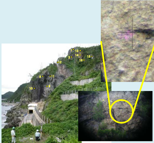
能登半島地震で不安定化した岩盤斜面の変位計測に活用
