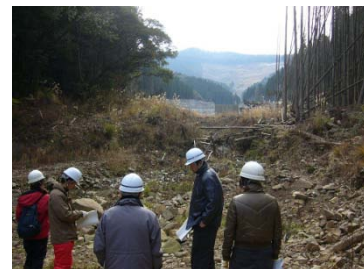
技術指導、地方整備局との合同調査の様子（宮崎河川国道事務所）
