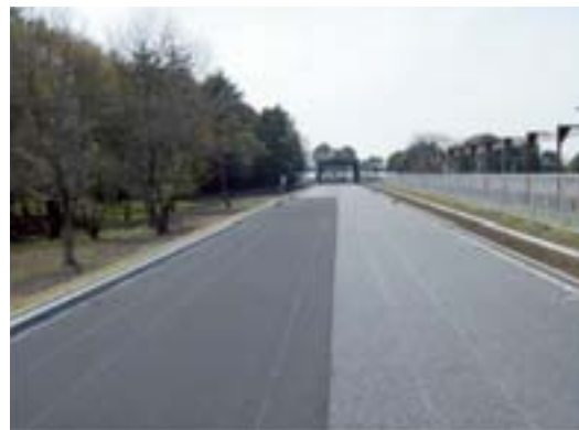
【タイヤ/路面騒音研究施設の新設】
