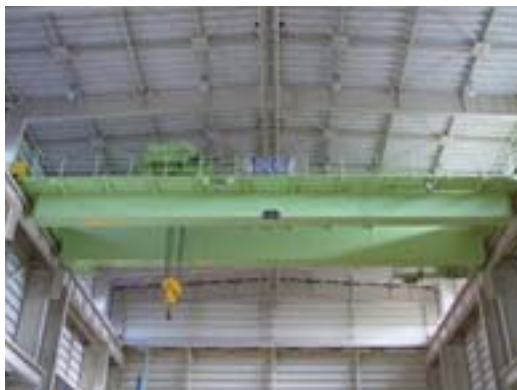
【三次元大型振動実験棟増築と大型クレーン】 増築棟に設置した100tクレーン
