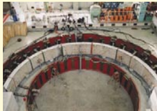
実物大供試体の作成 (トンネル)
