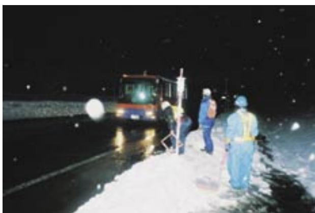
写真-1 一般国道18における計測状況
