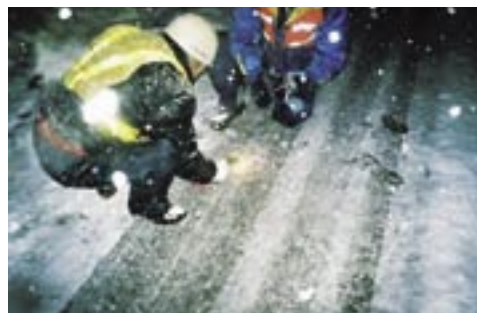
写真-2 路面計測状況
