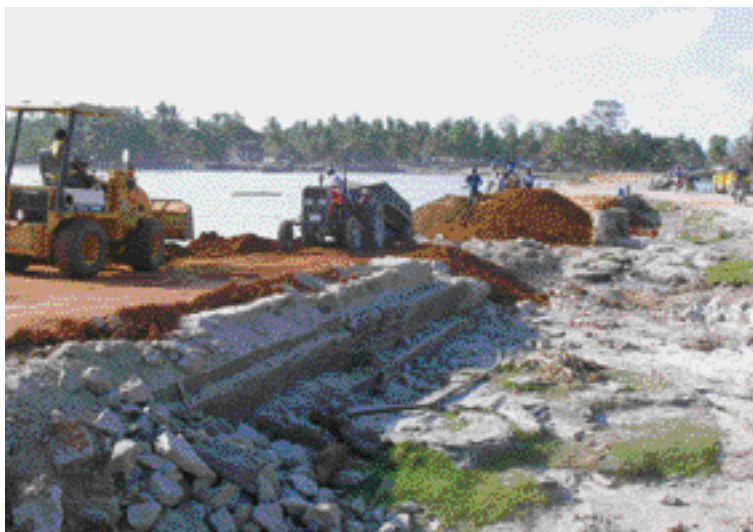
写真 - 2.3.2.9 津波により流出した盛土部の緊急復旧の状況（スリランカ）
