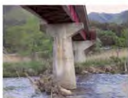
河川を横断する橋梁
