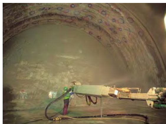
コンクリート吹きつけ作業 (模擬トンネル)
