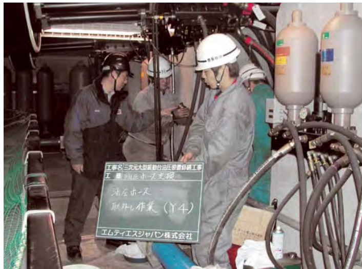
三次元大型振動台の油圧回路修繕三次元大型振動台油圧ユニット のサーボ弁オーバーホール（取付）
