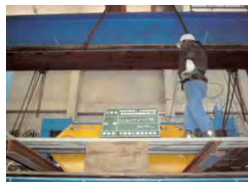
輪荷重走行試験機のライナ交換
