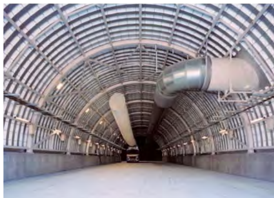
写真-7.1.1.5 実験棟内部
