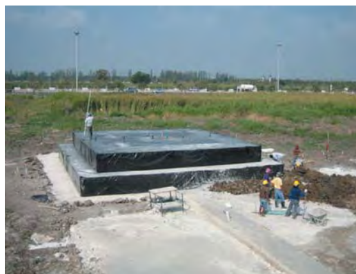
完成した試験盛土
