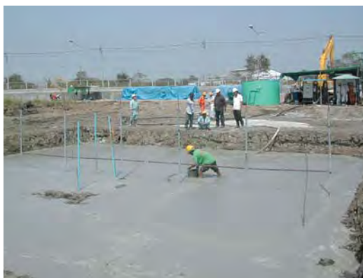
気泡混合土の打設
