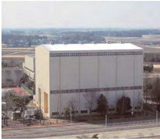
写真-7.1.1.6 改修前の実験棟外観
