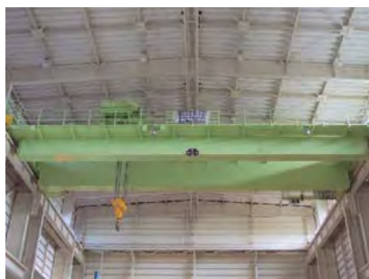
写真-7.1.1.3 100tクレーンの新設
