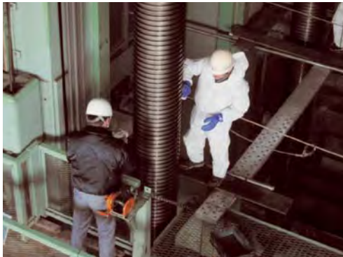
30MN大型構造部材万能試験機ネジ支柱の 点検清掃
