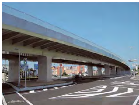
写真-2.2.1.1 交差点立体工事
