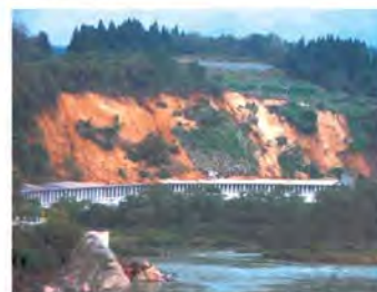
写真-6 県道333号中山竜光堀之内線でのスノーシェルター上部の斜面崩壊（国道17号が通行止めのため、緊急車両のみの代替ルートとなっている）
