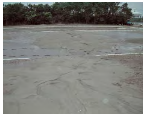
写真-1 地盤の液状化に伴う噴砂
