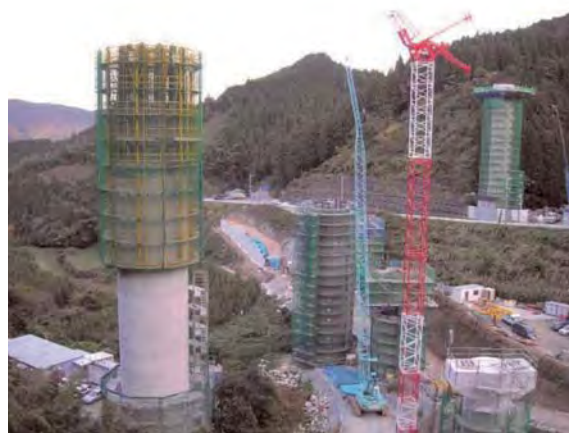
写真-2.3.2.7 施工状況全景
