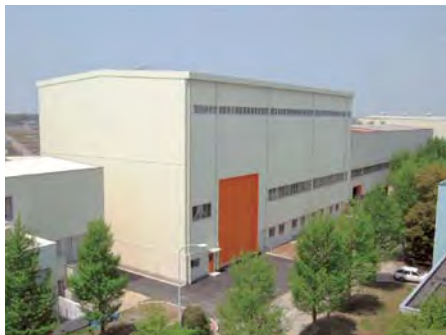
写真-7.1.1.1 実験棟の増改築
