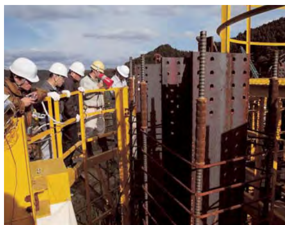
写真-2.3.2.8 施工中のピア見学状況
