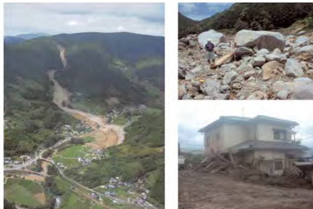
(左) 熊本県水俣市で発生した土石流 (国土交通省砂防部提供) (右上) 土石流により運ばれた巨石 (熊本県水俣市) (右下) 土石流・流木により被災した家屋 (福岡県太宰府)
