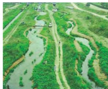
図-2 実験河川での出水の様子
