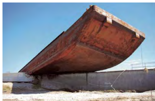
写真-2.3.2.14 高潮堤防を越流越波した高潮により防壁の上に乗り上げたバージ(ハリケーン「カトリーナ」)
