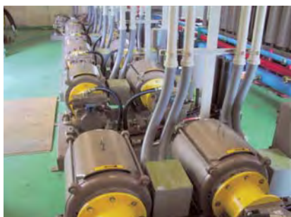
写真-7.1.1.2 油圧システムの改良
