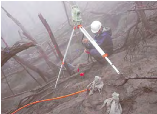
写真 現地での測量
