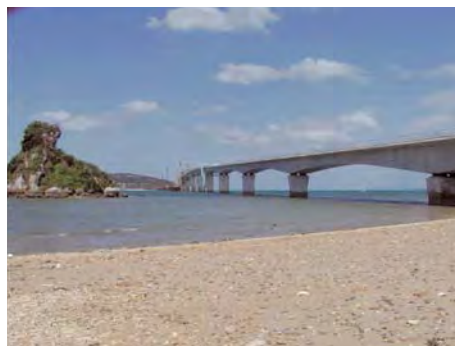
写真-2.2.1.3 長大コンクリート橋 (写真提供沖縄県)
