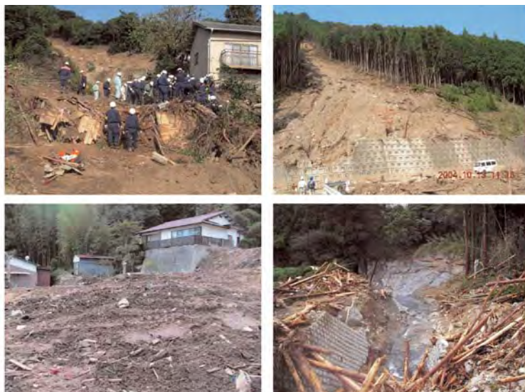
写真-2.3.1.3 16年度豪雨による土砂災害
