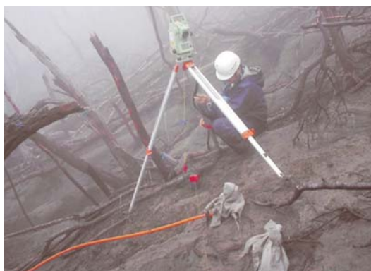
写真 現地での測量
