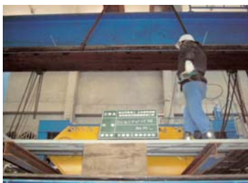
輪荷重走行試験機のライナ交換
