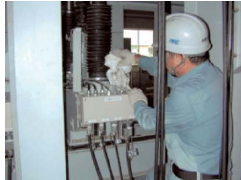
不等沈下発生装置の伝動機器の点検
