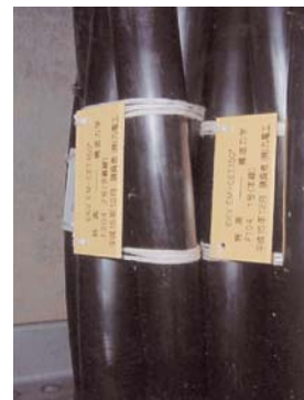
写真-7.1.1.8 更新した受変電設備 (サブ変電所) (高圧電力を200V・100V等に変電して実験棟内の試験設備や照明・換気設備等へ供給するもの。)
