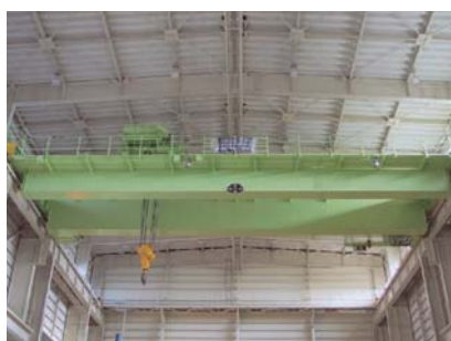
写真-7.1.1.3 100tクレーンの新設
