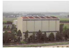
改修後の実験棟外観
