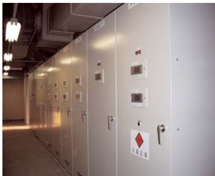
写真-7.1.1.7 更新した高圧ケーブル (特別高圧受変電施設から左写真のサブ変電所へ送電する6000Vケーブル。)
