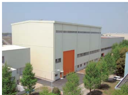
写真-7.1.1.1 実験棟の増改築
