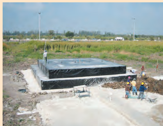
写真－3 完成した試験盛土
