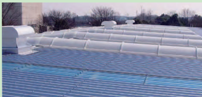
【改修により新しくなった屋根】
