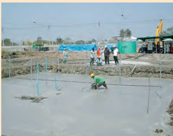
写真－2 気泡混合土の打設
