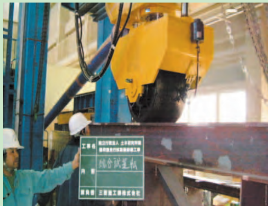
【輪荷重走向試験機の伝動装置分解整備】 (総合試運転状況)
