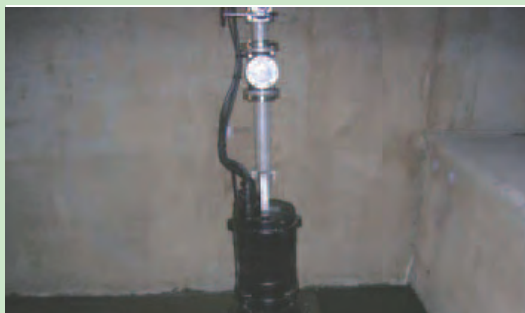
【改修した排水設備（ポンプ部）分】
