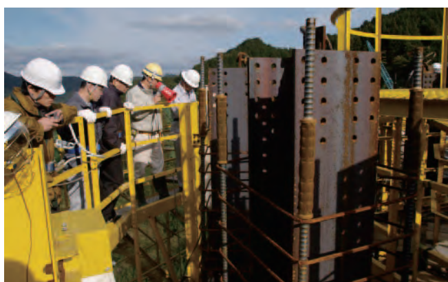
写真－2.3.2.7 3H工法の現場説明会開催状況
