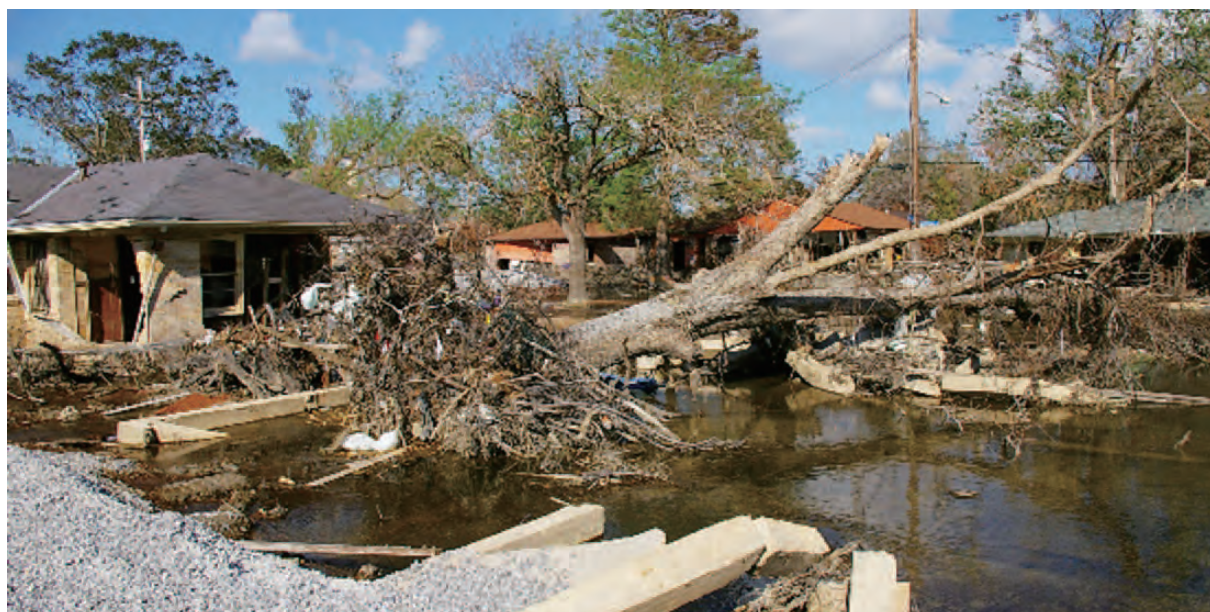
写真－ 2.3.2.13 London Ave. Canalの破堤地点の被害状況
