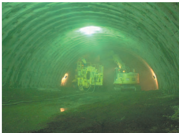
写真-2 機械掘削時の粉じん発生状況
