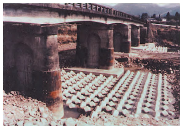
写真-2 洗掘防止工（根固め工）
