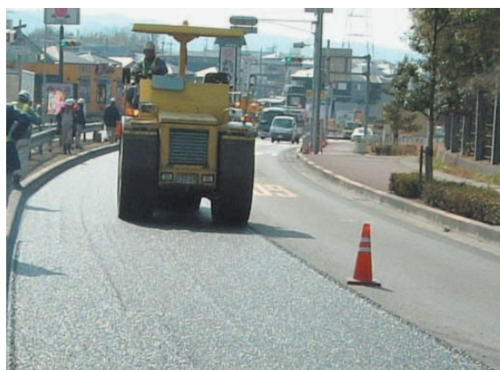
写真-1 再生排水性舗装の試験施工状況
