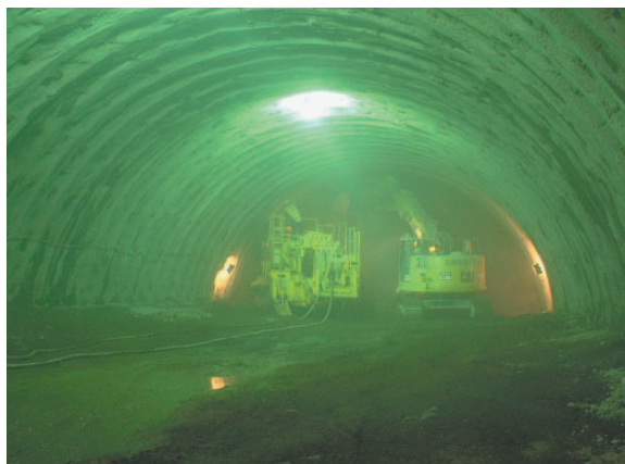
写真-2 機械掘削時の粉じん発生状況
