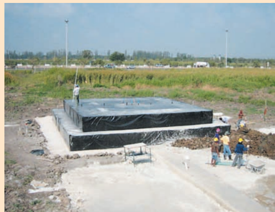
写真－3 完成した試験盛土
