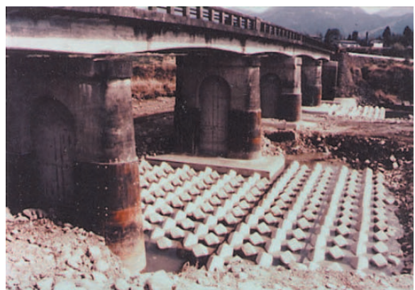
写真-2 洗掘防止工（根固め工）
