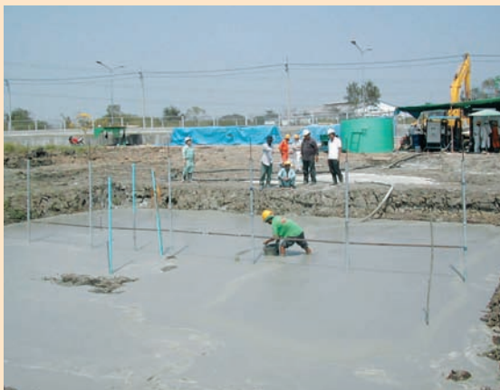
写真－2 気泡混合土の打設
