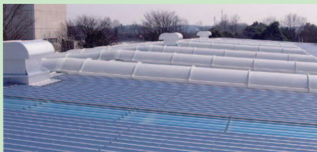
【改修により新しくなった屋根】
