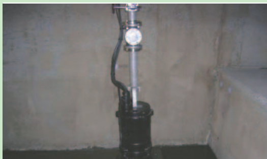
【改修した排水設備（ポンプ部）分】
