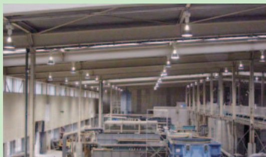
【改修した照明設備】
