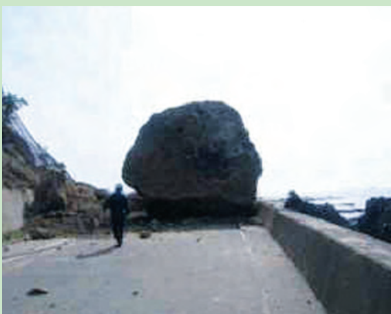
【輪島市市道道下深見線落石事故の調査】
