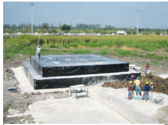
写真 気泡混合土試験盛土
