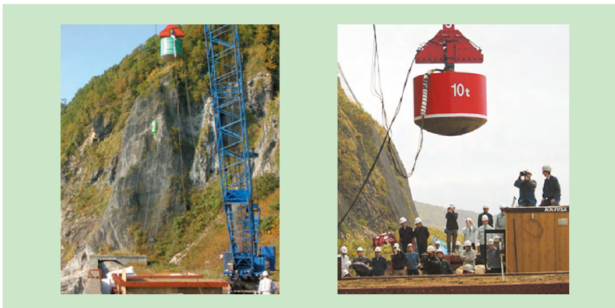
写真－1.5.2.20 実構造物衝撃実験の様子
