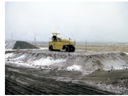
写真 冬期土工施工状況
