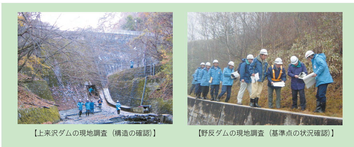
写真－1.5.1.5 不正のあったダムに関する現地立入検査の様子
