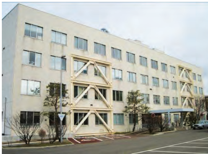
写真－6.1.1.2 耐震改修した管理棟
