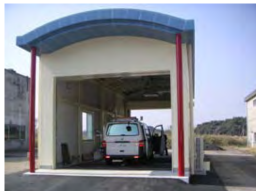
写真-9.1 新設したFWD検定施設
