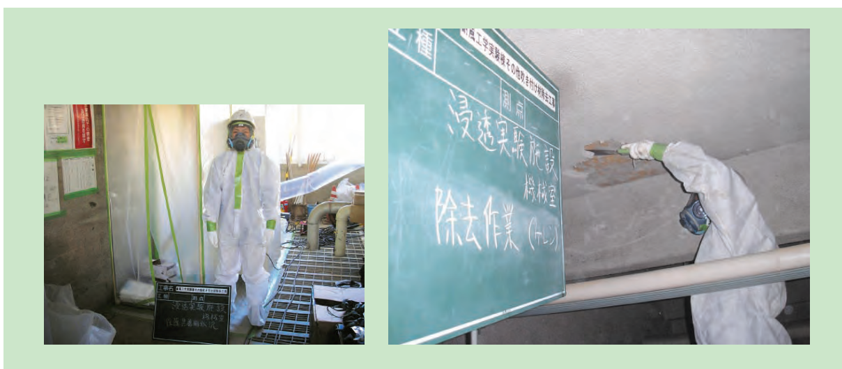
写真－6.1.1.3 アスベスト対策のための研究施設等改修
