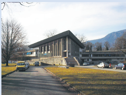
Cemagref グルノーブル支所の全景
