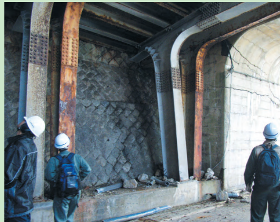
【国道 249 号八世乃（はせの）洞門内部の損傷調査】
