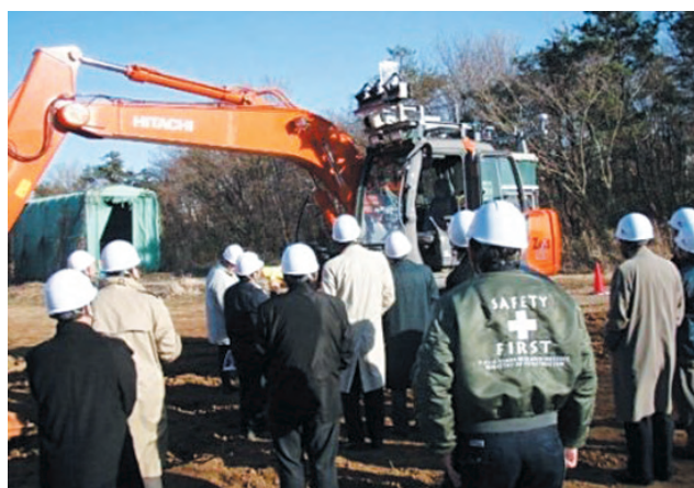
写真－ 1. 5. 2.17 開発した油圧ショベルのデモンストレーション
