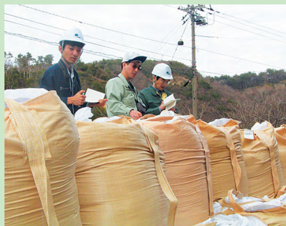
【斜面崩壊への応急対策（土のうの設置）とその効果の確認の様子】
