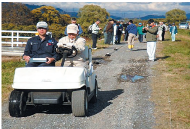
写真－1.5.2.18 千曲川堤防における公開現地調査
