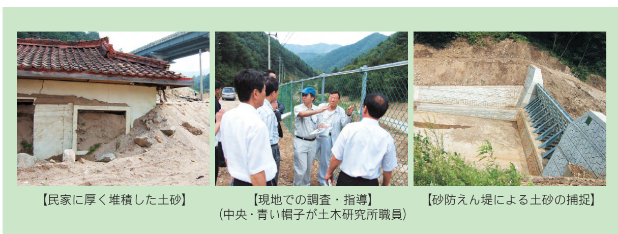
写真－1.5.1.4 韓国で発生した土砂災害に対する現地調査と対策についての指導
