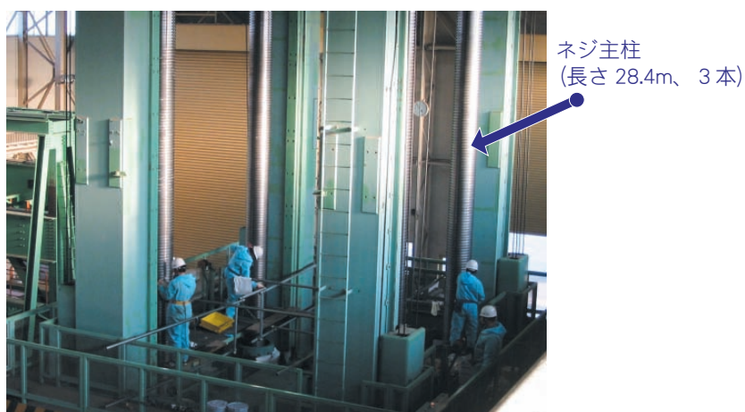
【30MN 大型構造部材万能試験機のネジ主柱整備】
