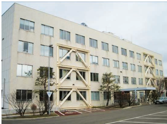
写真－6.1.1.2 耐震改修した管理棟
