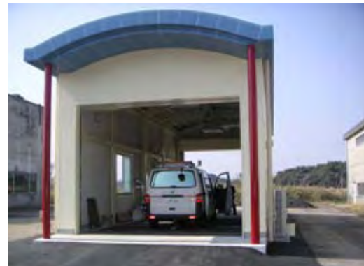
写真-9.1 新設したFWD検定施設
