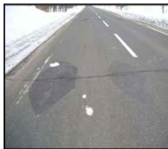
写真 温度応力によるひび割れ
