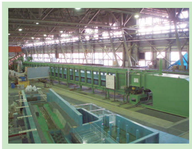
写真－7.1.1.2 寒地河川水理実験設備改修
