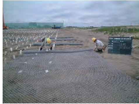
写真 11.5 敷き金網併用プラスチックドレーン工法の施工状況
