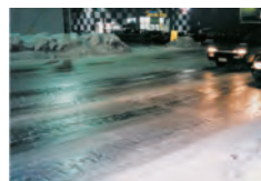
写真 7.1 つるつる路面の発生状況
