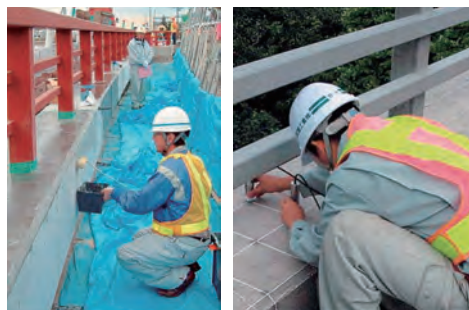
写真 11.2 表面含浸材によるコンクリートの耐久性向上
