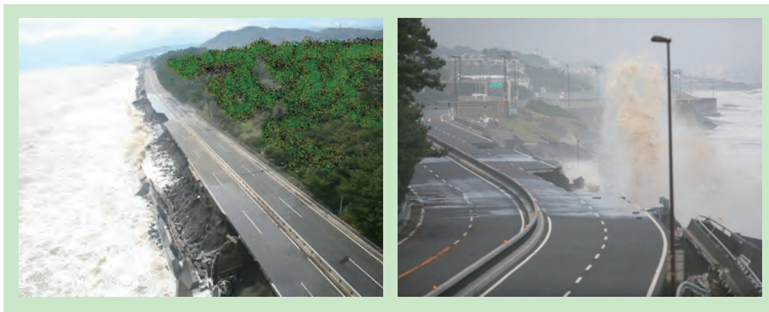
写真－1.5.1.5 西湘バイパス構造物崩落の状況
