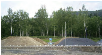
図-3 現地盛土実験の様子
