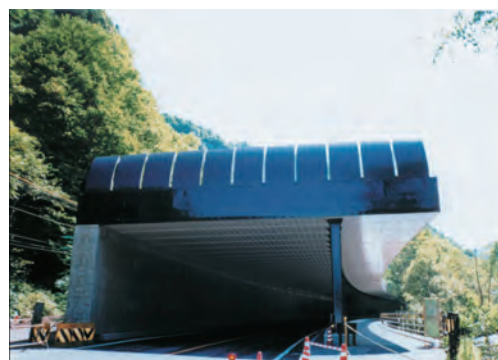
写真 6.2 道路防災工（落石覆道）
