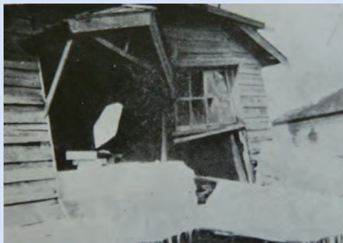
写真-1 1952年十勝沖地震では、津波とともに遡上した流水により多くの家屋が被害を受けた(根室測候所蔵、1952年十勝沖地震調査報告書より)
