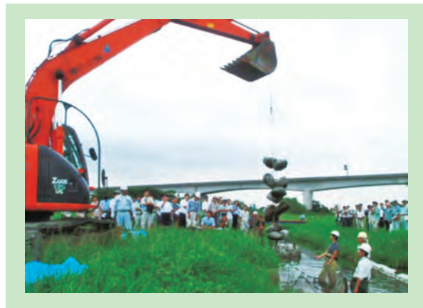
写真-1.5.2.12 ワイヤーで連結した石礫を重機で吊り上げる
