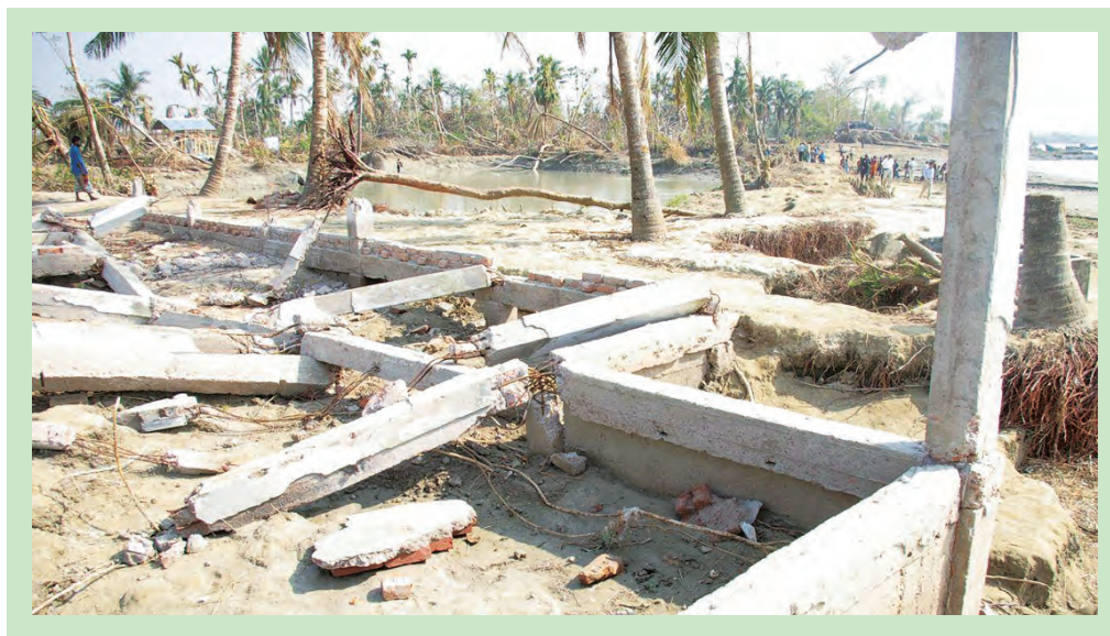
写真－1.5.2.15 バングラディッシュサイクロン被害
