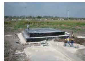
気泡混合土の試験盛土
