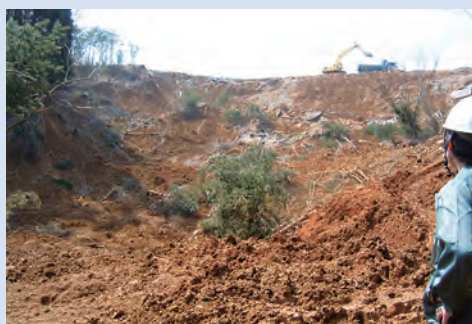
写真－2 道路盛土の現地調査状況 (能登半島地震)
