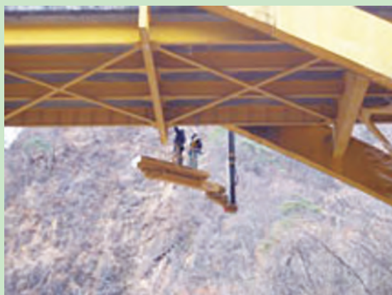
【橋梁点検車による調査】
