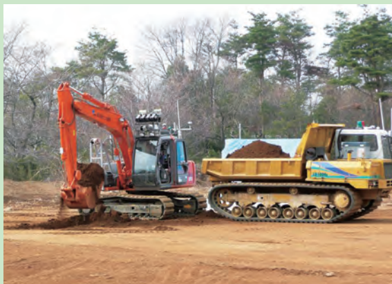
自動掘削・自動積込の状況
