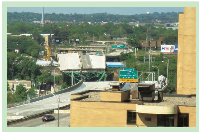
写真－1.5.2.17 ミネアポリスI-W橋落橋遠景
