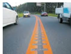
写真 7.4 正面衝突事故対策(ランブルストリップ)の開発
