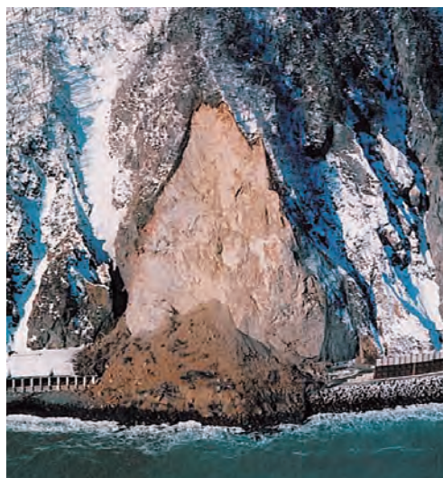
写真 6.1 えりもの斜面崩壊 (H16.1)
