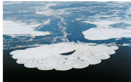
図 5.1 サロマ湖口流氷制御施設
