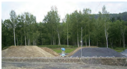
図-3 現地盛土実験の様子
