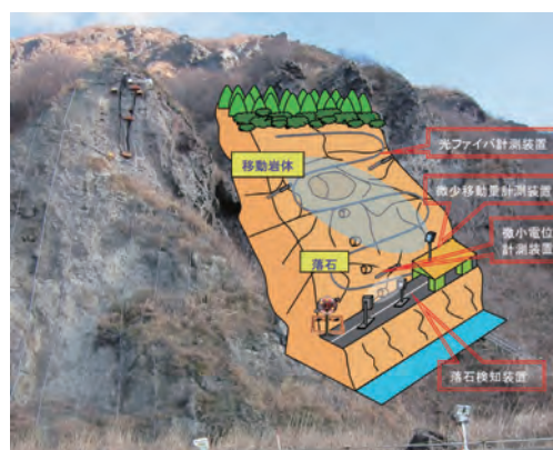
図 6.1 多様な計測機器を用いた岩盤調査
