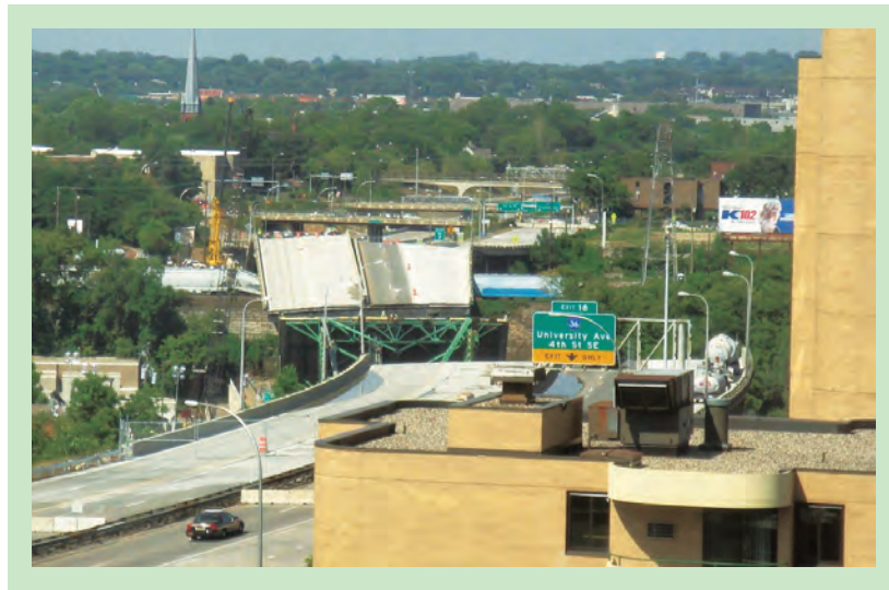
写真－1.5.2.17 ミネアポリスI-94橋落橋遠景
