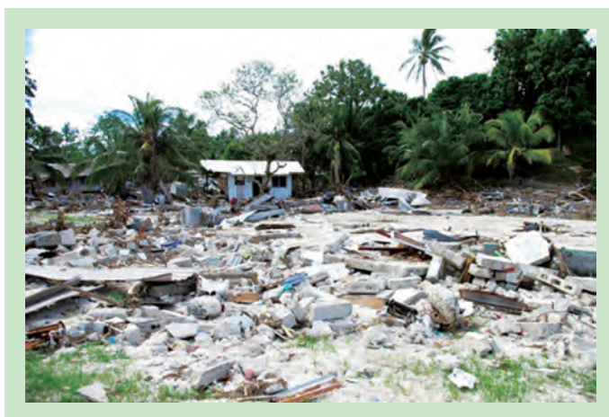
写真－1.5.2.14 ソロモン沖ギゾ島南部ティティアナでの津波被害状況
