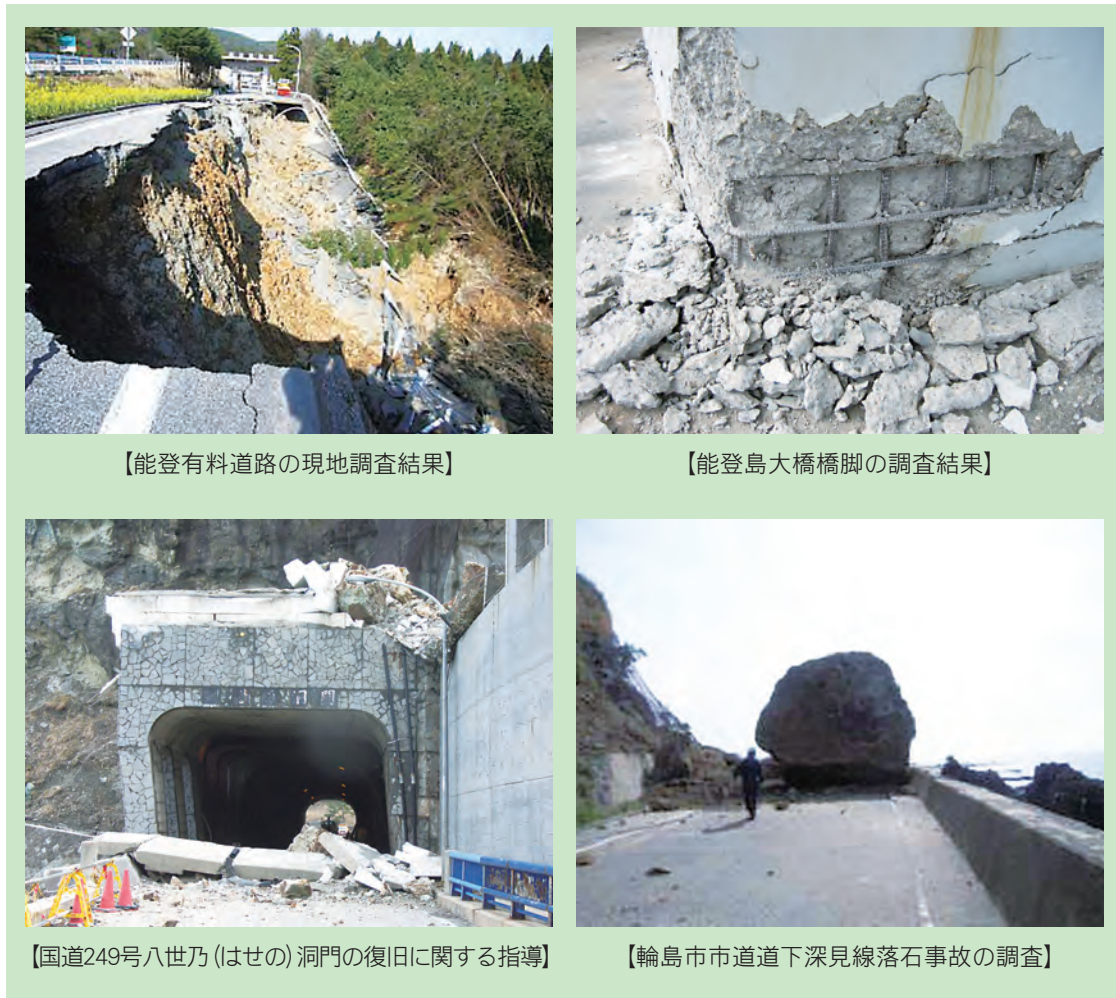
写真－1.5.1.2 能登半島地震における被害調査と復旧指導の状況
