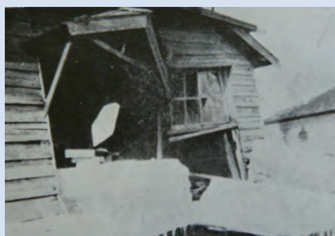
写真-1 1952年十勝沖地震では、津波とともに遡上した流水により多くの家屋が被害を受けた(根室測候所蔵、1952年十勝沖地震調査報告書より)
