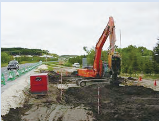
写真－1 新しい対策工の施工の様子
