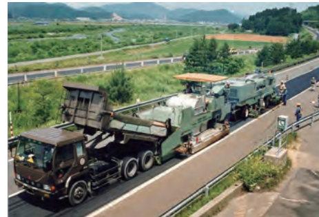
路上表層再生工法の例
