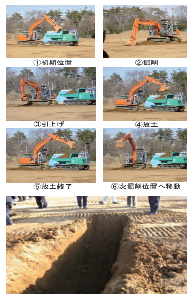
自動掘削作業終了後の出来形 自動制御による掘削作業
