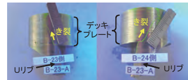
図-2 着目溶接部のき裂
