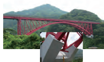
H16年新潟県中越地震とH19年新潟県中越沖地震による橋梁の被害分析と耐震補強効果の検証解析
