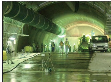
伸縮風管による粉じん対策技術
