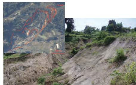
地すべり斜面の侵食の状況 (2006年6月)
