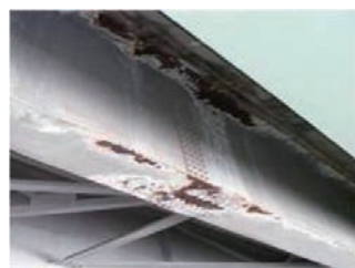
写真 10.1 金属溶射橋梁の状況
