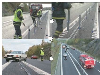
緊急時の解放例（右上から：ワイヤーを外し、中間支柱を外し、車両を通過させる）
