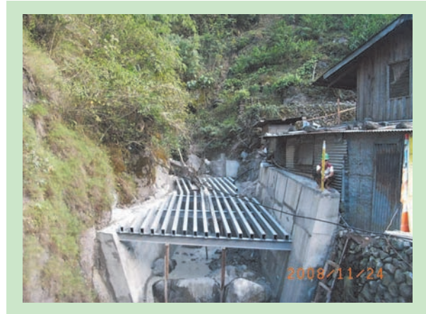
写真- 1.6.3 フィリピンのバギオ市での土石流減勢工試験施工完成直後の様子（平成 20 年 11 月）
