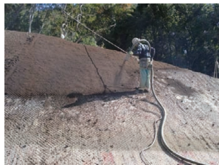
写真 12.4 緑化基盤用ピートモス代替開発品の試験施工状況
