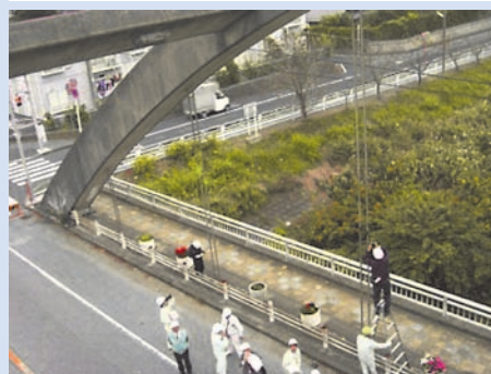
CAESAR では、道路管理者からの依頼を受け、迅速に現地調査を実施しています。
