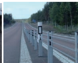
写真 7.10 ワイヤーロープ式防護柵
