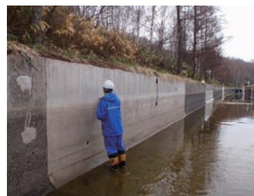
写真 17.1 試験施工区間での目視調査状況 (セメント系)
