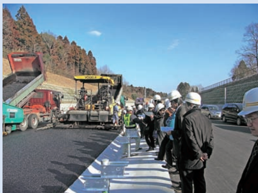
写真-2 舗装工事現場の視察
