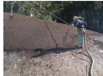
写真-1 法面への吹き付け時の様子
