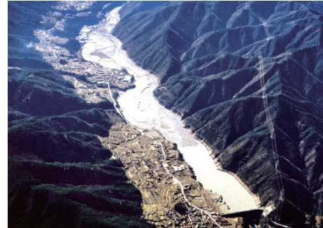
写真 14.1 堆砂の進行した貯水池
