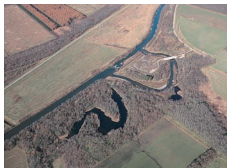
写真 15.1 標津川蛇行復元試験地
