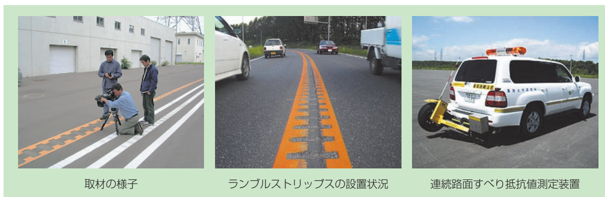
写真-1.5.12 ランブルストリップスと連続路面すべり抵抗値測定装置
