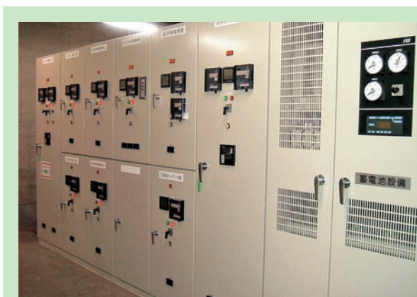
写真-7.1.3 部材耐震強度実験施設受変電設備改修
