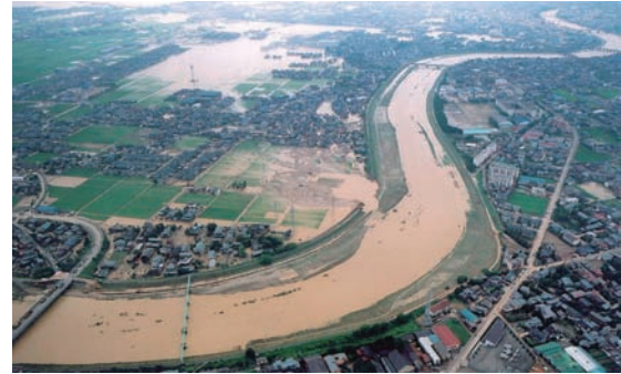
写真 2.1 平成 16 年新潟豪雨洪水災害における五十嵐川の破堤
