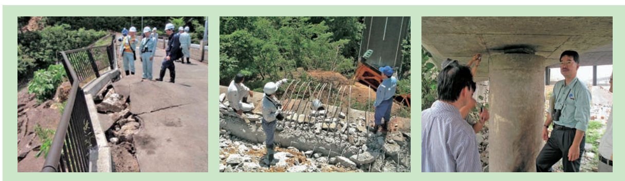
ダムの安全性確認（石淵ダム）
