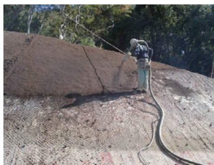
写真 12.4 緑化基盤用ピートモス代替開発品の試験施工状況
