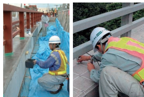
写真 11.2 コンクリートの耐久性向上のための表面含浸材の塗布、計測状況
