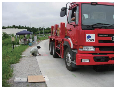
写真 9.1 静的荷重試験
