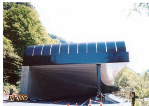
写真 6.2 道路防災工 (落石覆道)
