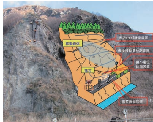
図 6.1 多様な計測機器を用いた岩盤調査
