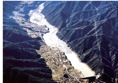
写真 14.1 堆砂の進行した貯水池
