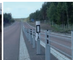
写真 7.10 ワイヤーロープ式防護柵
