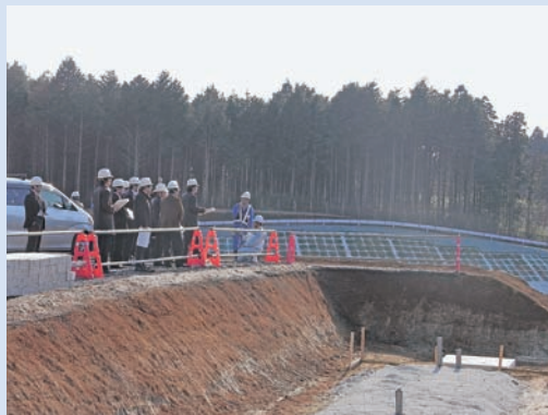
写真-1 盛土工事現場の視察
