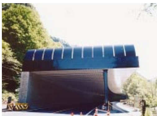
写真6.2 道路防災工（落石覆道）
