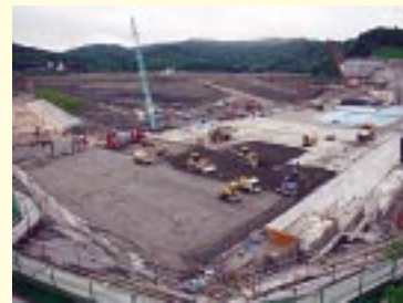
建設中の当別ダム(北海道)
