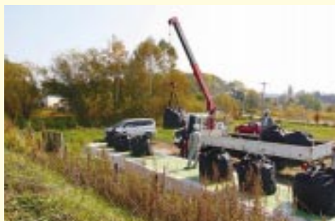
(c) 大型土のう設置
