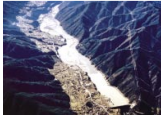
写真 14.1 堆砂の進行した貯水池
