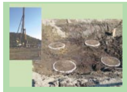
写真 - 1.5.21 ALiCC工法の施工状況
