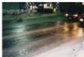
写真7.1 つるつる路面の発生状況
