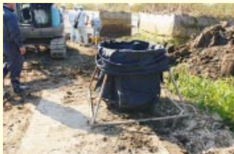
(a) 大型土のう
