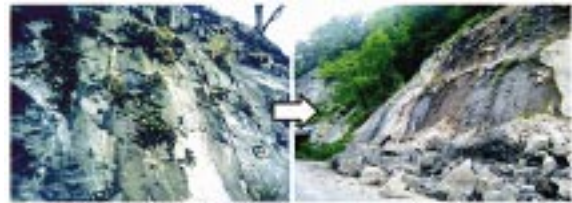
(平成8年度点検時) (地震後) 亀裂が多数発達していた吹付のり面の崩壊事例
