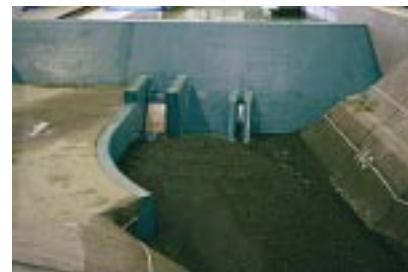
排砂実施状況（通水後の河床）
