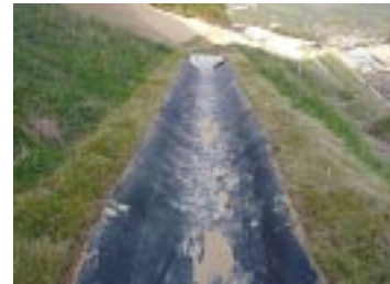
のり面小段の排水溝の試験施工
