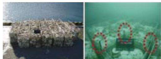
写真5.3 実用化に向けて規模を拡大した貝殻礁 左側：貝殻礁全景 右側：設置状況 (丸印が採水パイプ)
