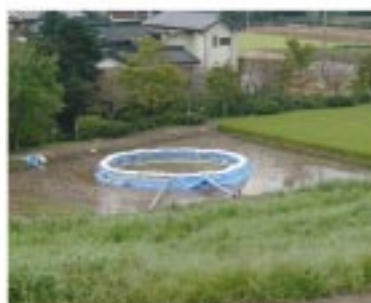
図2.4 基礎地盤漏水
