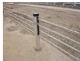
写真7.9 ワイヤーロープ式防護柵
