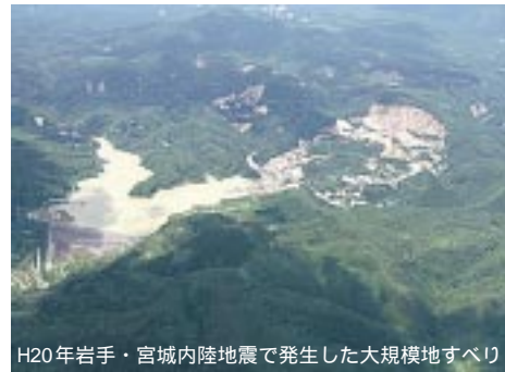
図4.3 土砂災害発生例
