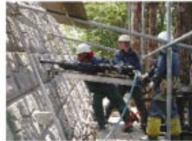
水平排水パイプの打設
