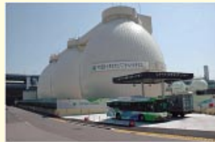
神戸バイオガスステーション
