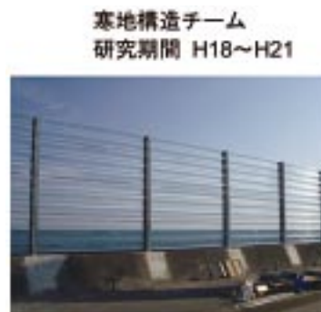
新型越波柵の現場設置状況
