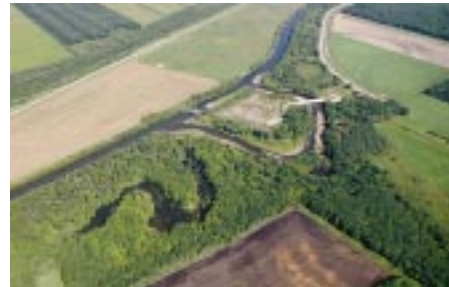
写真 15.1 標津川蛇行復元試験地
