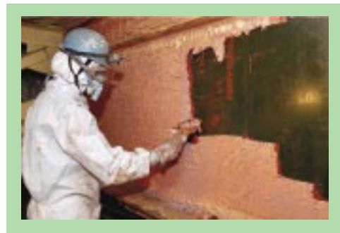
写真 - 1.5.20 インパイロワン工法の施工状況
