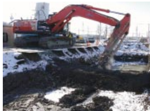
写真115 冬期中層混合処理施工状況
