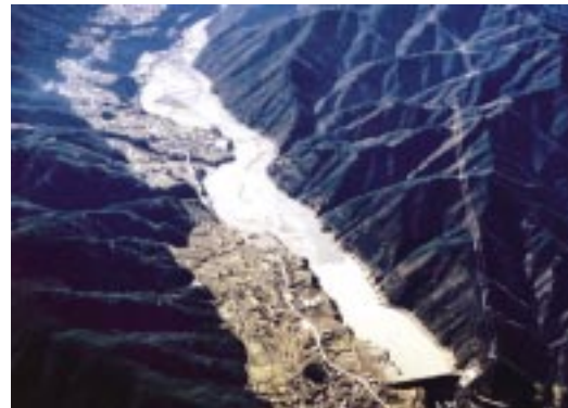
写真 14.1 堆砂の進行した貯水池
