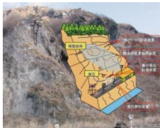
図6.1 多様な計測機器を用いた岩盤調査
