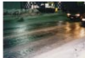
写真7.1 つるつる路面の発生状況
