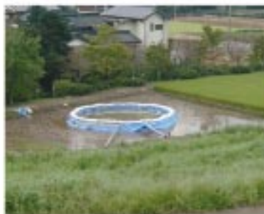
図24 基礎地盤漏水
