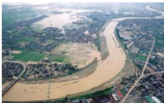
図21 平成16年新潟豪雨洪水災害における五十嵐川の破堤
