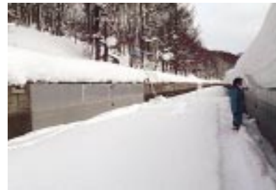
写真17.1 試験施工区間での目視調査状況
