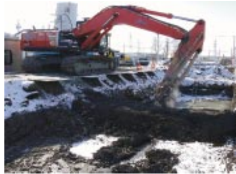
写真115 冬期中層混合処理施工状況
