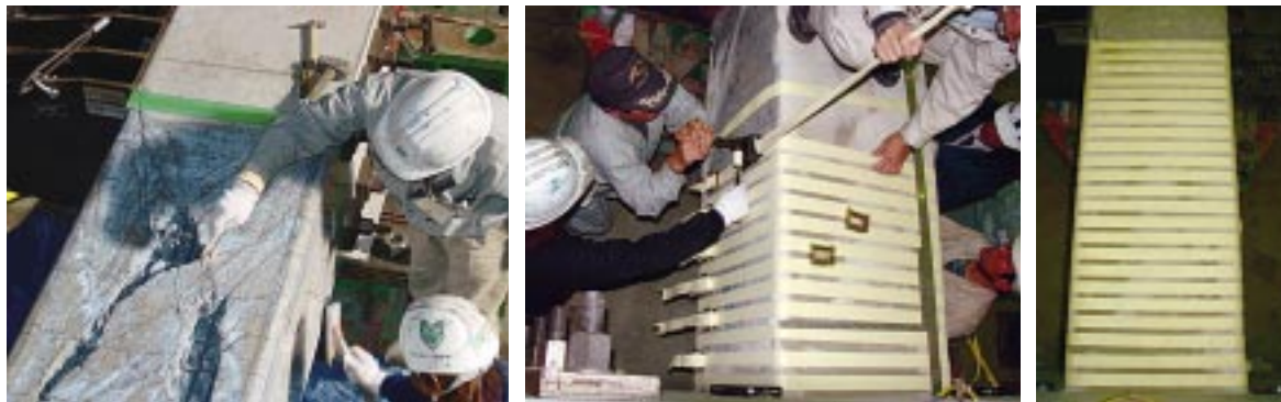
図 - 1 機械式定着繊維バンド巻立て工法による応急復旧
