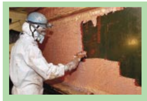
写真 - 1.5.20 インパイロワン工法の施工状況
