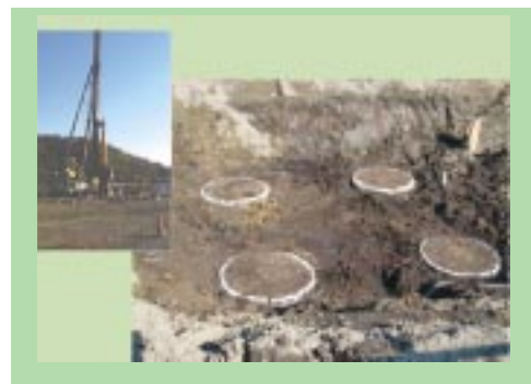
写真 - 1.5.21 ALiCC工法の施工状況
