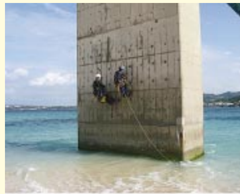
写真-2 瀬底大橋における塩害調査
