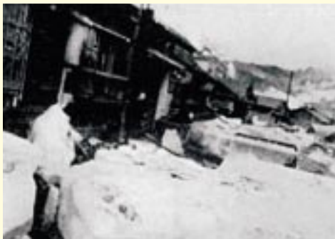
昭和27年十勝沖地震では、津波とともに遡上した流氷により多くの家屋が被害を受けた（根室測候所蔵、1952年十勝沖地震調査報告書より）
