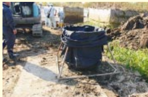
(a) 大型土のう
