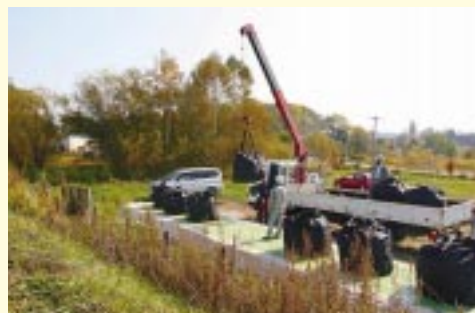
(c) 大型土のう設置
