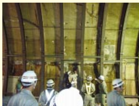
現地調査の状況
