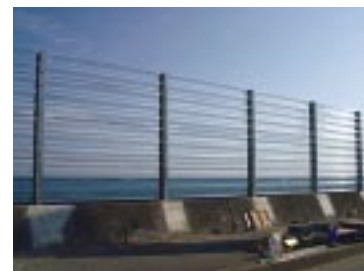
新型越波柵の現場設置状況
