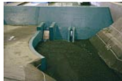
排砂実施状況 (通水後の河床)
