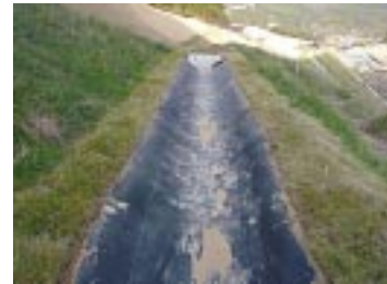
のり面小段の排水溝の試験施工
