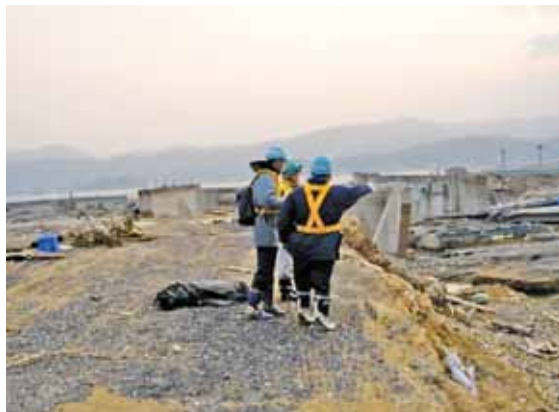
津波により被災した道路橋の調査
