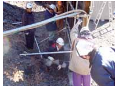
現場実証試験の実施状況
