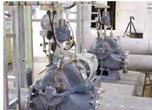
写真-7.1.2 ダム水理実験施設 (ポンプ・配管更新)
