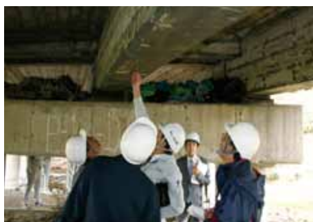
「橋梁点検勉強会 in かもえない 神恵内」 における橋梁点検現地実習
