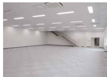
写真-6.1.1 改修された「水災害・リスクマネジメント研究センター棟」
