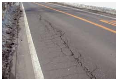
写真11.4 融解期の路床の支持力低下によるクラック
