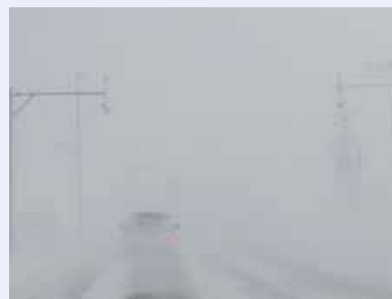
吹雪視程障害の発生状況
