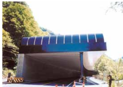
写真6.2 道路防災工（落石覆道）
