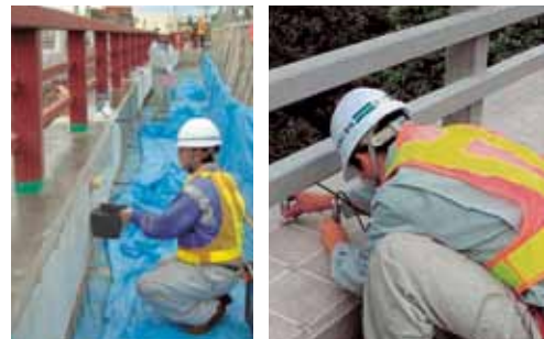
写真11.2 コンクリートの耐久性向上のための表面含浸材の塗布、計測状況
