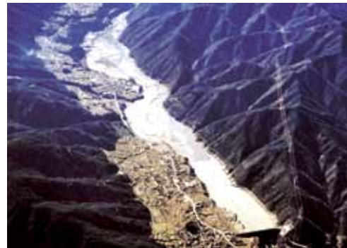
図14.1 堆砂の進行した貯水池
