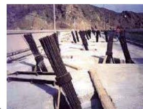
アンカー工法
