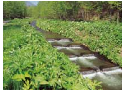
写真-1 調査フィールドの農業排水路
