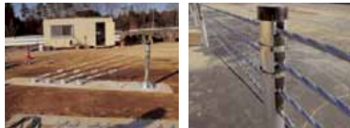
写真7.9 ワイヤーロープ式防護柵
