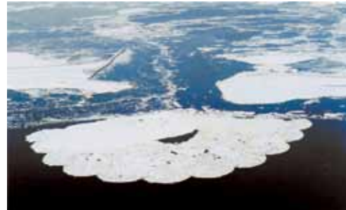
写真5.1 サロマ湖口流水制御施設
