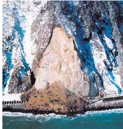
写真6.1 えりもの斜面崩壊（H16.1）
