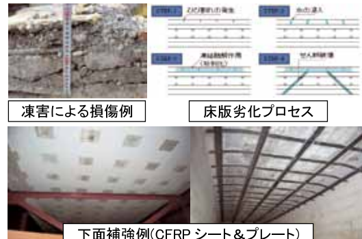
図11.3 凍害等の影響を受けるRC床版の補修補強
