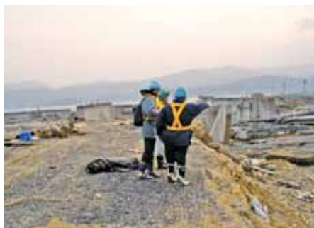
津波により被災した道路橋の調査
