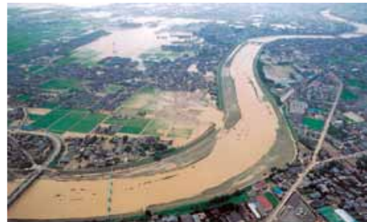
図2.1 平成16年新潟豪雨洪水災害における五十嵐川の破堤
