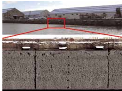
図5.6 音響カメラを用いて撮影したデータによるモザイク図 (陸上部+水中部)
