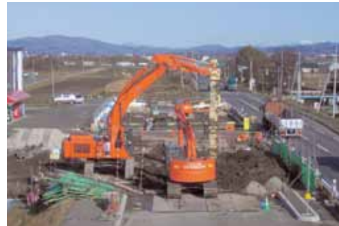
図11.1 中層混合処理工法の施工状況
